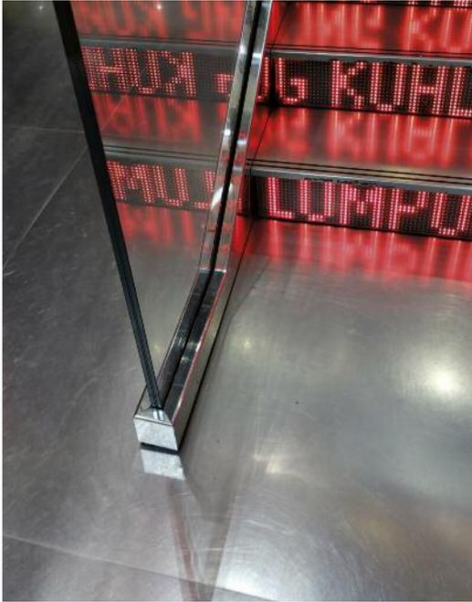
Robust und leicht zu reinigen verleihen Bodenfliesen aus Edelstahl Rostfrei Räumen einen unverwechselbaren Charakter. In diesem Kaufhaus definieren sie neue Bereiche und sorgen durch ihren ungerichteten Schliff für die nötige Rutschhemmung.
