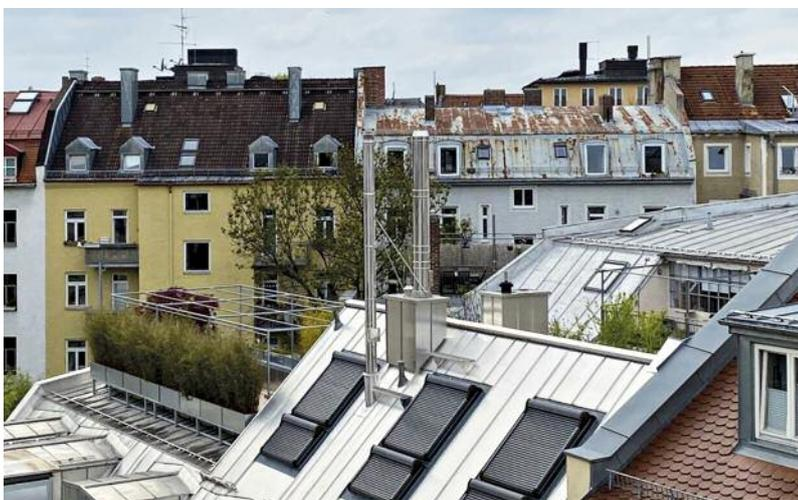
Moderne Brennwerttechnik nutzt die im Abgas enthaltene Restwärme. Die nun kühlere Abluft kondensiert jedoch an den Wandungen alter Schornsteine und lässt diese allmählich versotten. Starre oder flexible Kamineinzugsrohre aus nichtrostendem Stahl lassen sich von oben in bestehende Schornsteine einbringen. Sie minimieren bauliche Eingriffe, sind feuchtigkeitsundurchlässig und beständig gegen aggressive Kondensate.
