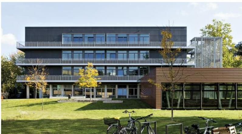
Energie- und brandschutztechnisch saniert präsentiert sich das Köln-Kolleg mit neuer Fassadengestaltung. Hinterlüftete Paneele aus Glasfaserbeton nehmen die massive Materialität der Sichtbetonfassade aus den frühen 1970er-Jahren auf. Für die notwendigen Fluchtwege sorgen umlaufende Balkone und außenliegende Treppen. Das semi-transparente Edeldstahlgewebe der Brüstungen und um die Treppentürme vermittelt Leichtigkeit und wirkt zudem raumbildend.
