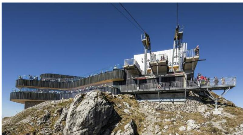
Das Restaurant auf dem 2.224 m hohen Nebelhorn wurde unter weitgehender Nutzung der alten Fundamente als kombinierter Stahl-Holz-Bau neu errichtet. Die über eine großzügige Terrasse damit verbundene Gipfelstation der Seilbahn blieb erhalten. Der funktionale Pultdachbau wurde um einige Nebenräume ergänzt und setzt sich durch seine neue allseitige Umhüllung mit Edelstahl-Falzblechen deutlich vom Restaurant mit dessen geschwungener Linienführung ab.
