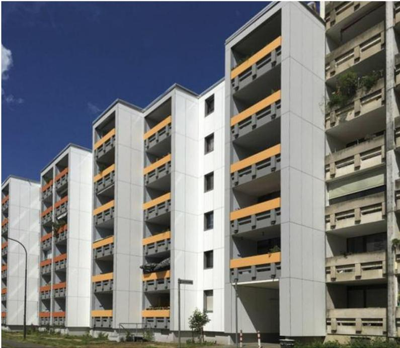
Geringe Wärmedämmung, Wärmebrücken und hohe Energiekosten – Probleme, die zahllose Bestandsgebäude aus den 1970er-Jahren betreffen. Die Wohnanlage in Troisdorf wurde bereits in zwei Bauabschnitten energetisch saniert. Stabwerke aus Edelstahl Rostfrei übertragen die Wind- und Eigenlasten der neuen Faserzementplatten durch Dämmung und Luftschicht in den Rohbau, bei minimalen Verlusten durch Wärmebrücken.
