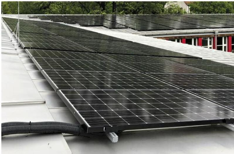
Solarpaneele können in unterschiedlichen Winkeln durchdringungsfrei an den Falzen von Edelstahldächern befestigt werden.
