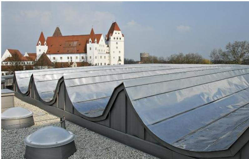
Nicht nur Flachdächer, auch andere Dachformen mit flachgeneigten Bereichen, wie Tonnen- oder Bogendächer sowie Geometrien mit quer zur Dachneigung verlaufenden Nähten profitieren von dem langlebigen, über Jahrzehnte erprobten Verfahren des Rollnahtschweißens.
