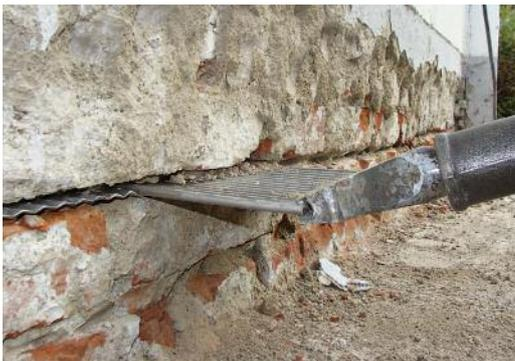
Beim Vibrationsverfahren werden Wellplatten aus Edelstahl Rostfrei von einem Spezialwerkzeug mit hydraulischem Druck in die Lagerfuge des Mauerwerks oder „weichen“ Naturstein eingetrieben. Die ineinandergreifenden Platten bilden sofort eine durchgängige horizontale Sperrschicht. Trennen und Isolieren erfolgen in einem einzigen Arbeitsgang und auch das nachträgliche Verpressen von Fugen entfällt.
