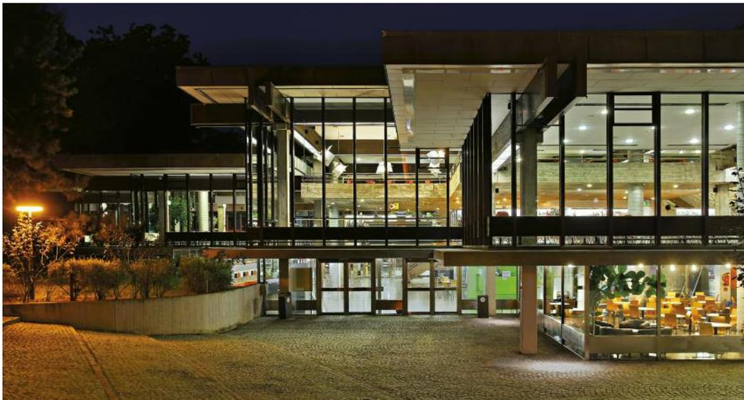
Im Zuge einer grundlegenden energetischen Sanierung erhielt die Mensa II der Uni Freiburg eine neue Glasfassade mit 3-fach Isolierverglasung. Im Sockelgeschoss kam dafür ein Profilsystem aus nichtrostendem Stahl zum Einsatz. Auch die bisherigen Eingangstüren aus flächigem Metall wurden durch verglaste Edelstahltüren ersetzt und unterstreichen nun die gestalterische Intention der ursprünglichen Architektur aus den frühen 1970er-Jahren.
