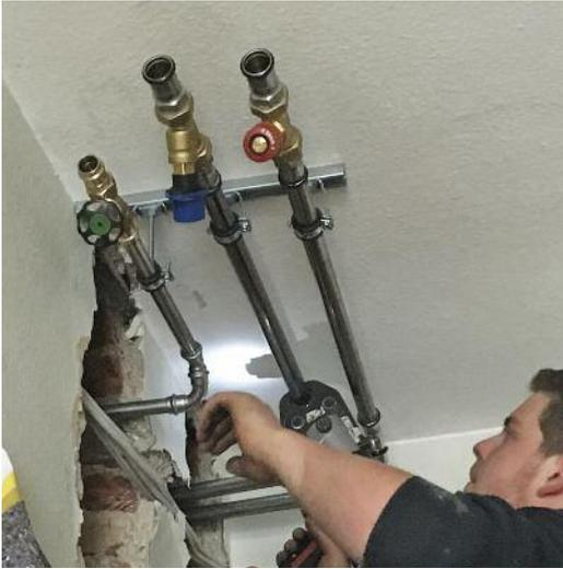
Zur mechanische Verpressung von Edelstahlrohren werden sogenannte Pressfittingsysteme eingesetzt. Die gute Umformbarkeit von nichtrostendem Stahl nutzend, erhalten die schnell und kostensparend zu installierenden Verbindungen ihre endgültige Festigkeit unmittelbar nach dem Fügeprozess.
