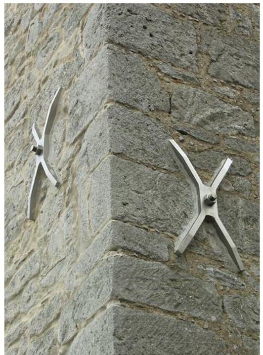
Gewindestangen mit Abstandhaltern zum optimalen Verpressen mit Mörtel im Bohrloch
