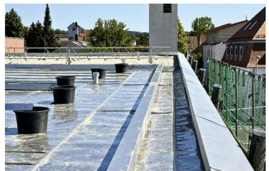
Schon wenige Jahre nach der Eröffnung des Deutschen Hopfenmuseums in Wolnzach zeigten sich erste Undichtigkeiten des Foliendaches. Der starkgeneigte Dachrand der neuen rollnahtgeschweißten Edelstahldeckung erhält die optische Leichtigkeit der Dachkonstruktion aus Brettschichtholz und bietet eine technisch sichere und langlebige Lösung.
