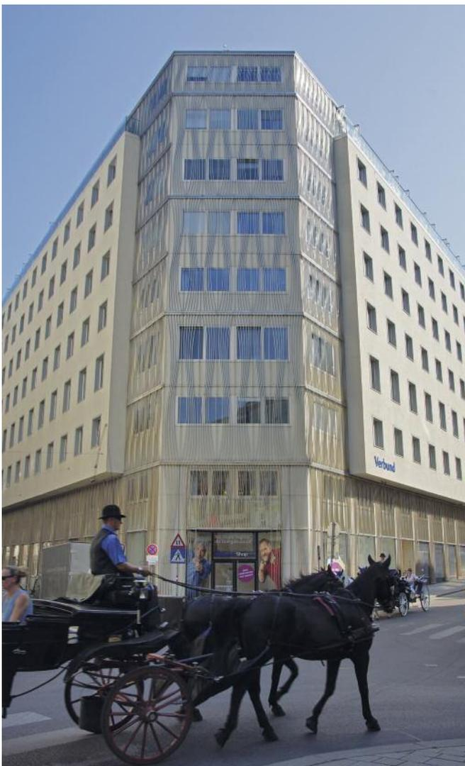
Das in den 1950er-Jahren erbaute Verwaltungs- gebäude der Verbund Zentrale liegt an der Freyung, einem der prominentesten Plätze in der Altstadt von Wien. Elemente aus wellen- förmig gebogenen und zueinander versetzen Rechteckrohren aus Edelstahl Rostfrei sind als zweite Schicht vor die sanierte Fassade ge- setzt und passen den neugeschoßigen Nach- kriegsbau durch seine geschoßübergreifende Gestaltung an den Maßstab der benachbarten historischen Gebäude an.
