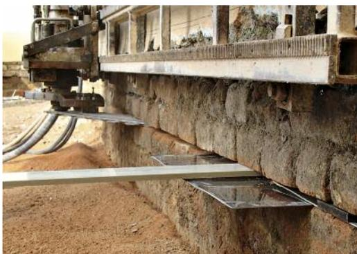
Sollen u.U. bauwerksschädliche Erschütterungen vermieden werden, bietet sich das Sägeverfahren an, bei dem das Mauerwerk im Nass- oder Trockenschneideverfahren abschnittsweise durchtrennt wird. Unmittelbar nach dem Sägen werden die nichtrostenden Stahlbleche überlappend eingeschoben. Hochfeste Kunststoffkeile sorgen vor dem abschließenden Verpressen der Sägefuge mit Quellmörtel für die Übertragung der Vertikallasten.
