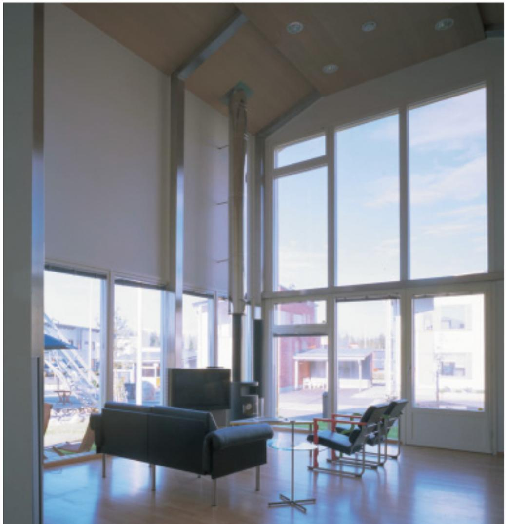
*Die in den sichtbaren Bereichen der innenliegenden Edelstahlrahmen geschliffene Oberfläche (Korn 220) reflektiert schimmernd das Licht.*
