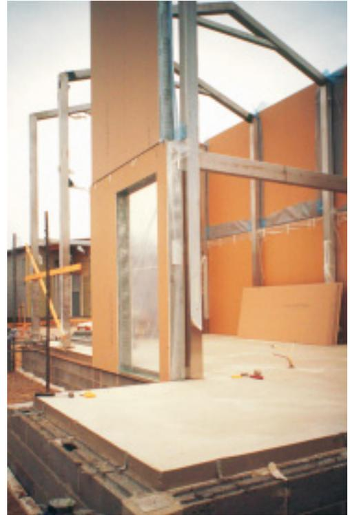
des Gebäudes. Während bei den Wandelementen geschlitzte Stahlleichtbauprofile mit Dämmung und beidseitiger Beplankung eingesetzt wurden, besteht die Tragkonstruktion der Dachelemente aus Holz.
