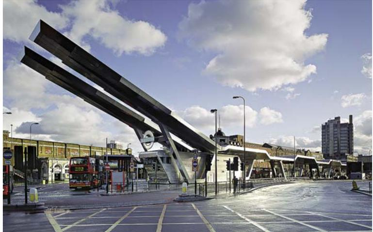
Die wellenförmige Struktur des langgestreckten Edelstahlbandes bildet in einer fließenden Abfolge Überdachung und Wartebereiche des Busbahnhofs.
