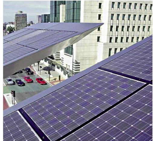
*Auf der Oberseite der Ausleger sind 168 Photovoltaikmodule integriert. Mit ihrer Jahresleistung von etwa 23.000 kWh decken sie rund 30% der für den Betrieb der Bushaltestelle benötigten elektrischen Energie ab.*
