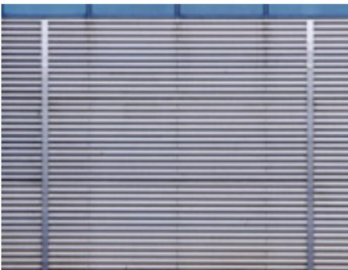
Ein weiteres, immer wiederkehrendes Fassadenelement sind profilierte 1,5 mm dicke Edelstahlbleche (Werkstoffnr. 1.4401). Die Oberflächen sind fein geschliffen (Korn 320) und gebürstet.
