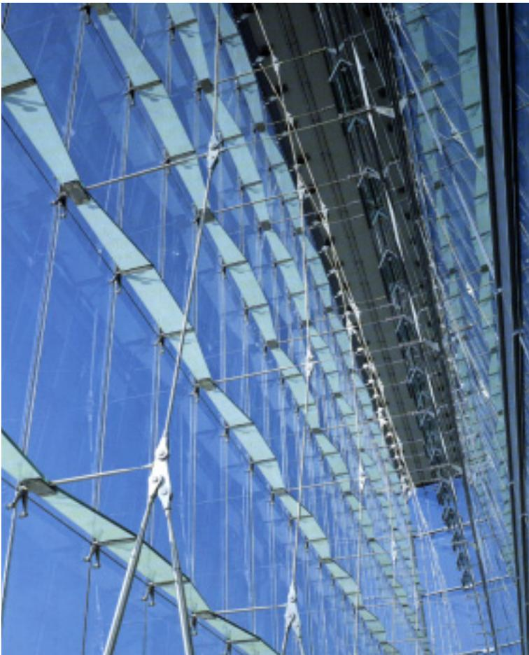
*Innenliegende, horizontal angeordnete Glas-schwerter steifen die hinterspannte Edelstahl-Zugstabfassade aus.*
