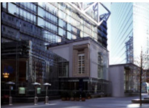
denkmalgeschützte Bestand wie in einer Vitrine, überdacht von einem rollnahtgeschweißten Edelstahldach mit matt-gestrahlter Oberfläche (Werkstoffnr. 1.4404).
