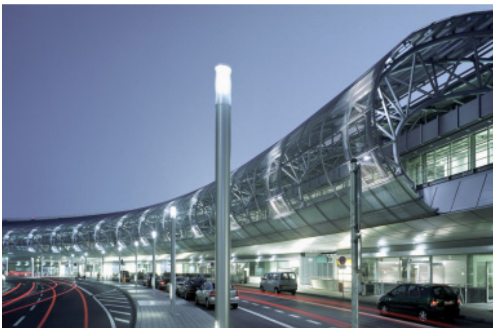
Die Träger des Hallendaches biegen sich über eine Länge von 400 m elliptisch um die Gleisführung der neuen Schwebbahntrasse. Die Stahl-Glas-Konstruktion ist an der Außenseite mit Edelstahlrohren überzogen.
