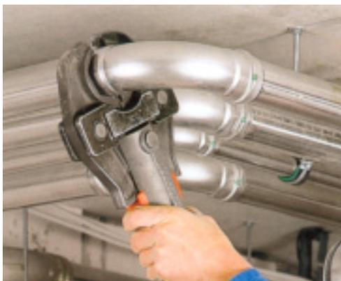
*Die Verbindung der Rohre erfolgt mit Presswerkzeugen, die über ein optisches Signal mögliche Fehler schon während des Verpressens anzeigen und somit die Dichtigkeit des Systems garantieren.*
