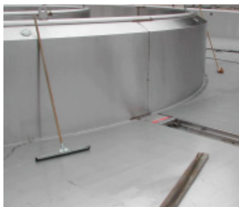
Im Rahmen der jährlichen Unterhaltsmaßnahmen werden die elementierten Abdeckungen der Wassereinströmrinnen entfernt.
