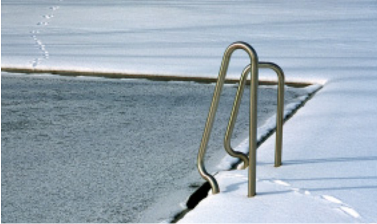
Für die Überwinterung von Schwimmbecken aus Edelstahl Rostfrei müssen keine besonderen Maßnahmen getroffen werden.
