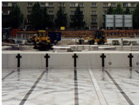
Die schwarzen Tauchstreifen auf dem Boden des Sportbeckens wurden elektrolytisch auf die Tafeln aufgebracht.
