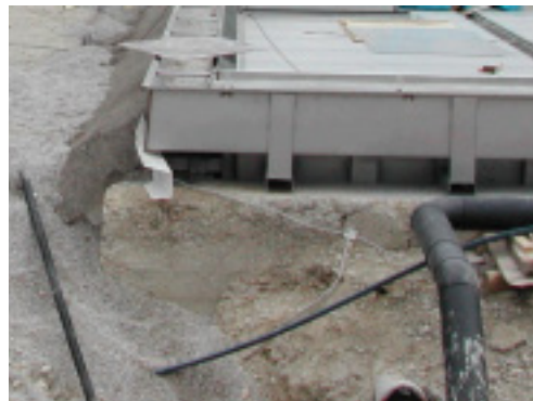
Die neue Überlaufrinne sitzt auf der alten Betonwanne.
