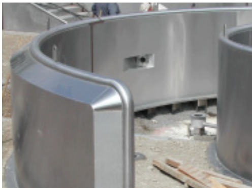
Die selbsttragenden Wände des Strömungs- kanals aus Edelstahl Rostfrei.
