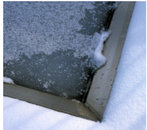
Die Erdwärme reicht aus, um das Anfrieren des Eises an der Beckenwand zu verhindern.
