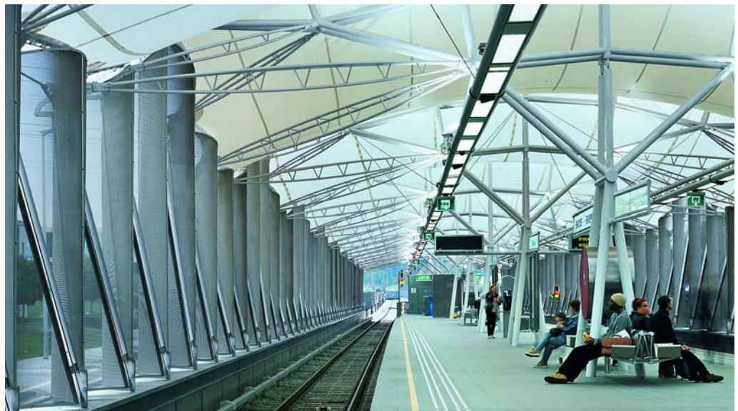
Die Bespannung der Wandflächen besteht aus einem Edelstahlgewebe (Werkstoff-Nr. 1.4404) mit 27% offenem Maschenanteil.
