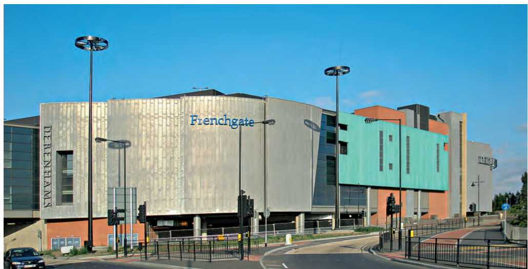
Walzmattierte Oberflächenausführung 2F bei einer vorgehängten Fassade. Foto: Aperam, Luxemburg (L)
