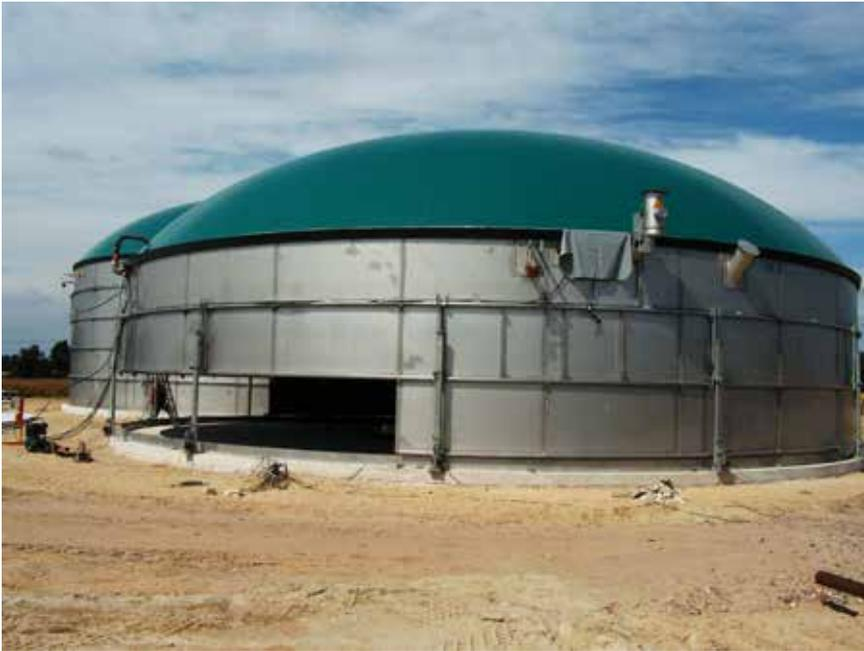
**Bild 19: Zusammenbau eines Fermenter-Tanks aus nichtrostendem Stahl (Foto: WELTEC BIOPOWER GmbH, Vechta)**
