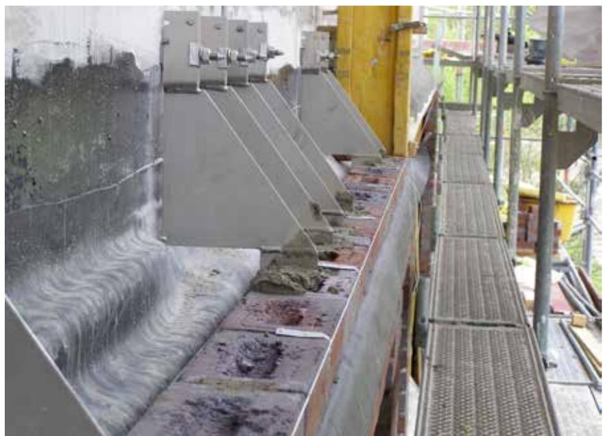
**Bild 18: Technisch-wirtschaftliche Alternative zu Standardausteniten: Klinkerabfangung aus nichtrostendem Lean-Duplexstahl (Foto: W. Modersohn GmbH & Co. KG, Spenge)**
