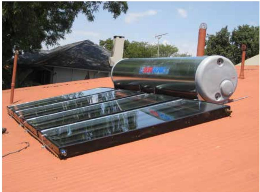
**Bild 12: Solarkollektor für die Warmwassererzeugung auf einem Gebäudedach mit drei Kollektorplatten und einem Warmwasser-Sammelbehälter [26]**
