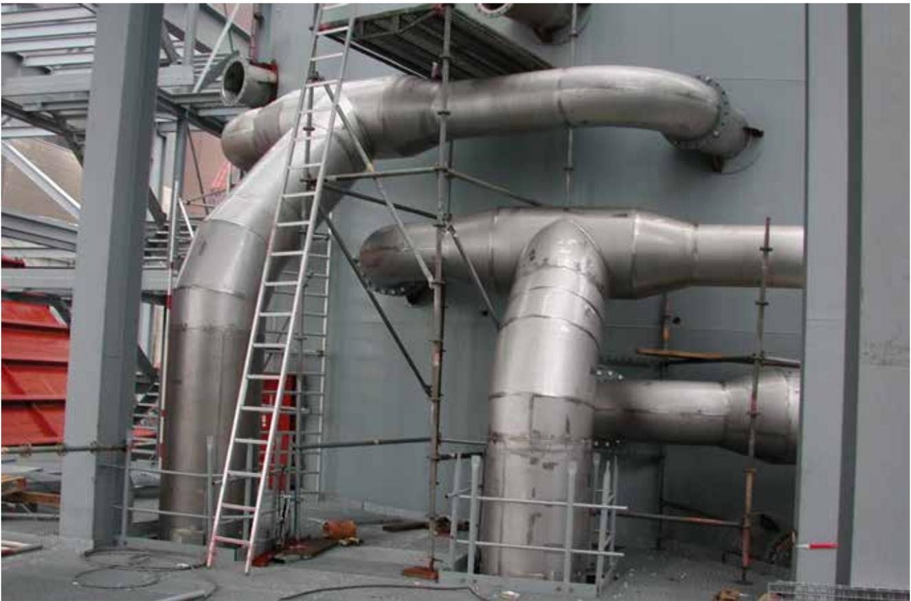
**Bild 4:** Umwälzleitungen aus dem hochlegierten nichtrostenden korrosionsbeständigen Stahl X1NiCrMoCuN25-20-7 (1.4529) eines Kraftwerks im niederrheinischen Braunkohlenrevier (Foto: Heinz Gothe GmbH & Co. KG, Mönchengladbach)
