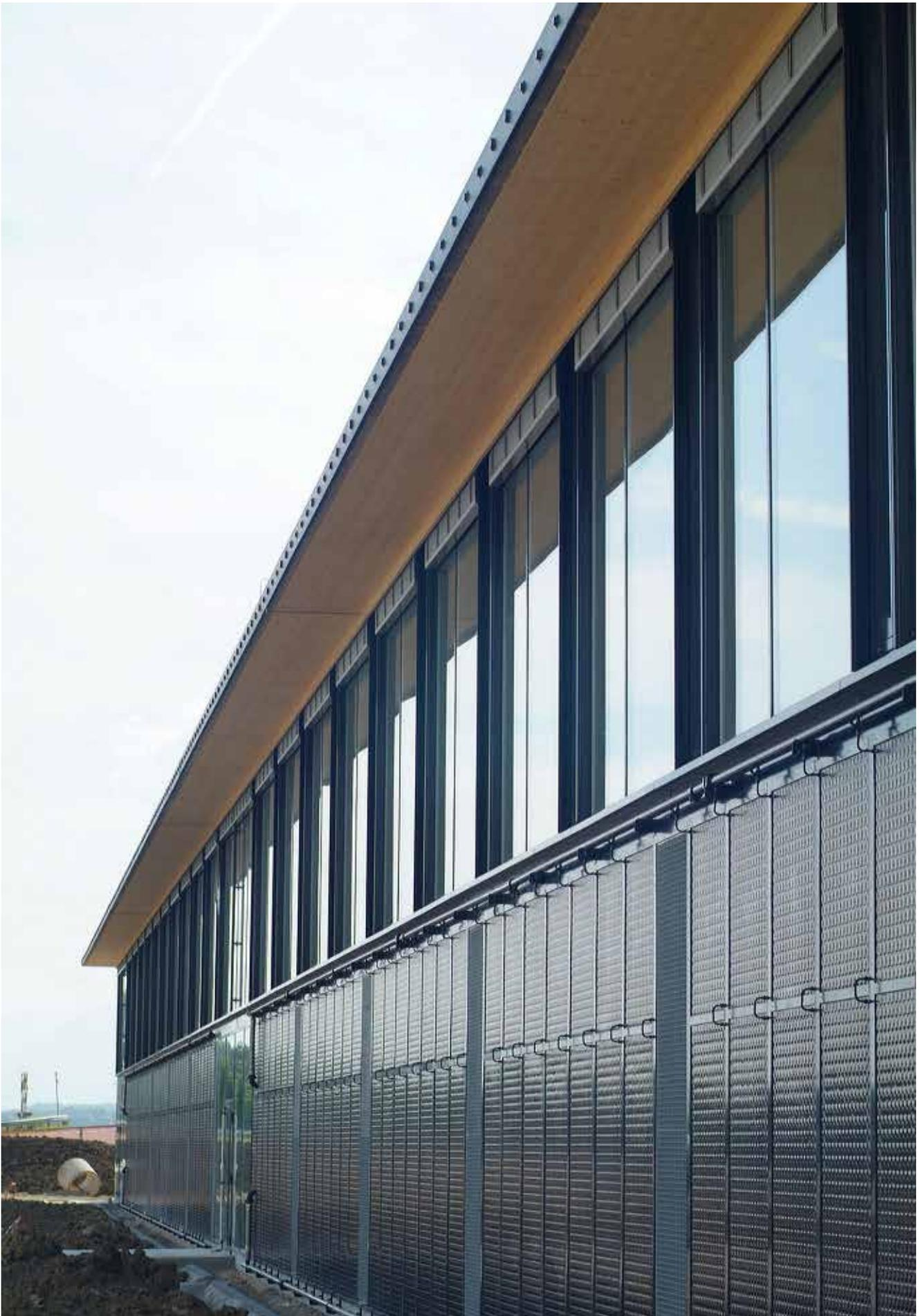
Bild 14: Doppelwandiger waffelartig geformter Solarkollektor als Paneelen an einer Gebäude-Außenwand, hergestellt aus schwarz verchromtem Edelstahl Rostfrei gemäß Bild 13 [26]
