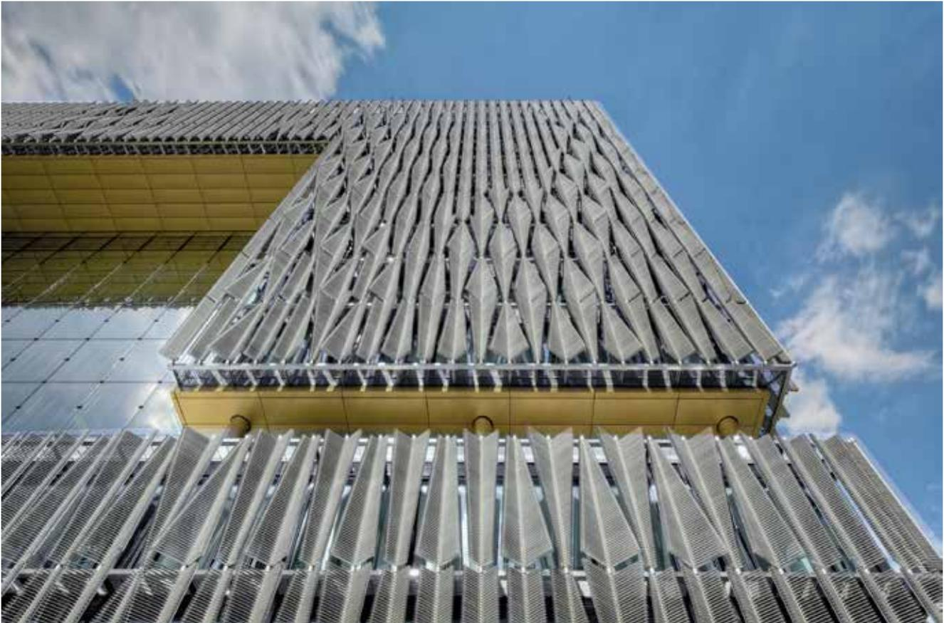
**Bild 17: Sonnenschutzsystem aus Edelstahl vor dem Bürogebäude des Stahl- und Technologiekonzerns ThyssenKrupp [20,32] (Foto: Günter Wett / Frener & Reifer Deutschland GmbH, Augsburg)**
