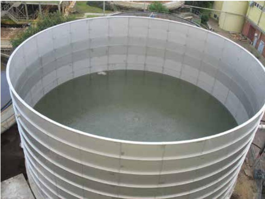
**Bild 20: Innenansicht des Vorratstanks einer Biogasanlage aus nichtrostendem Stahl (Foto: Erich Stallkamp ESTA GmbH, Dinklage)**
