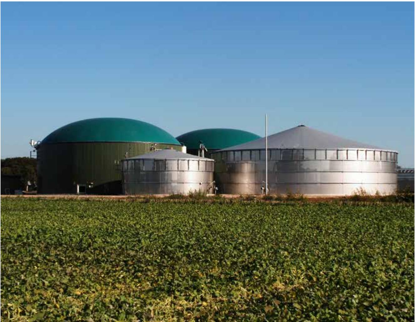
Bild 21: Ansicht von Vorrats- und Fermenter-Tanks einer Biogasanlage aus nichtrostendem Stahl (Foto: Erich Stallkamp ESTA GmbH, Dinklage)
