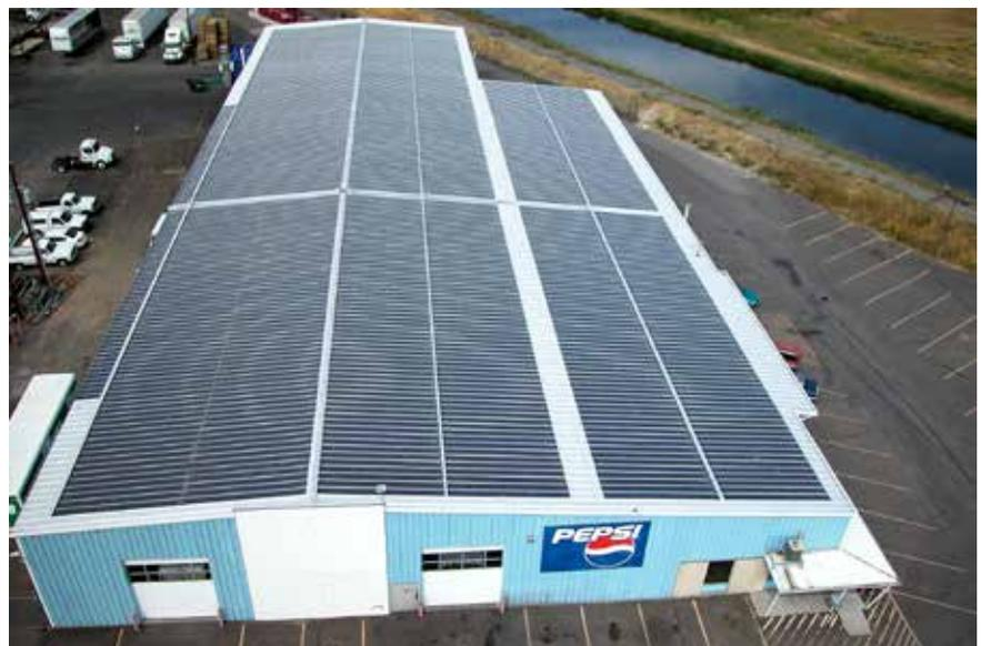
**Bild 9:** Amorphe Solarzellen lassen sich in idealer Weise auf Dachoberflächen aus Edelstahl Rostfrei verlegen [26]
