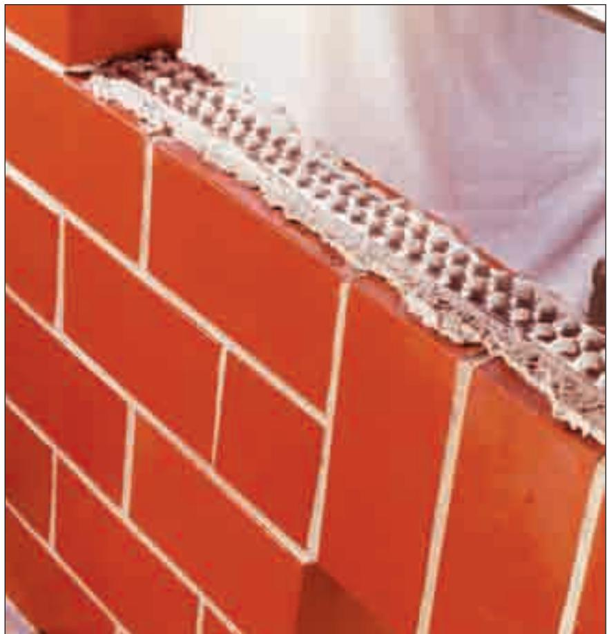
Bild 13: Sturzbereich mit Mauerwerksbewehrung
