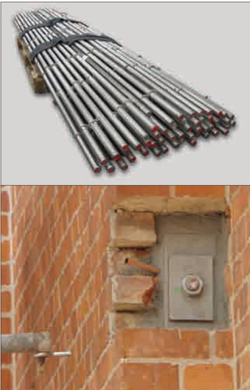
Bild 23: Zuganker aus Edelstahl rostfrei für das Vernadeln
