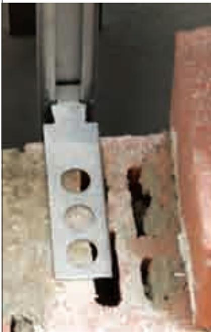
Bild 16: Verankerung der Außenschale von zweischaligem Mauerwerk im Attikabereich
