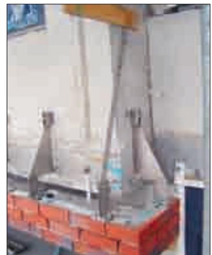
Bild 21: Anwendungsbeispiele für Abfangungen von Stürzen in der Außenschale von zweischaligem Mauerwerk
