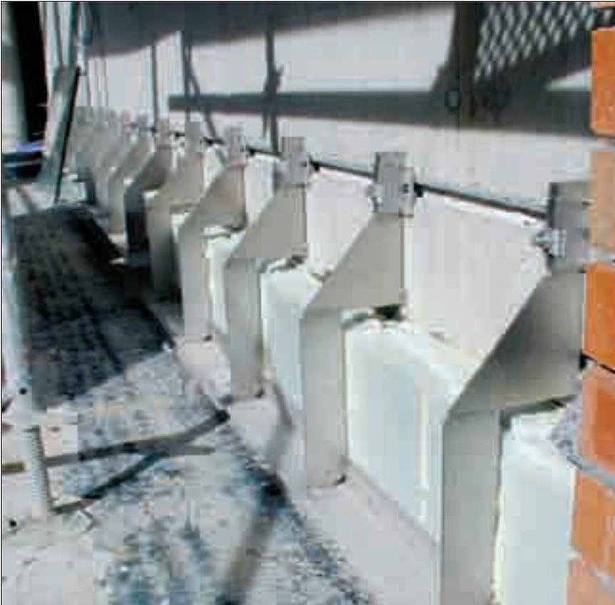
Bild 20: Anwendungsbeispiel für Sockelabfangungen für die Außenschale von zweischaligem Mauerwerk
