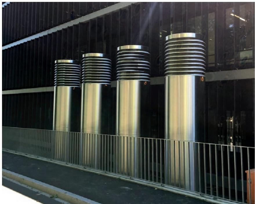
Bild 5: Lamellen für Frischluftzufuhr (Foto: Engelhardt GmbH (SES), Wassertrüdingen)
