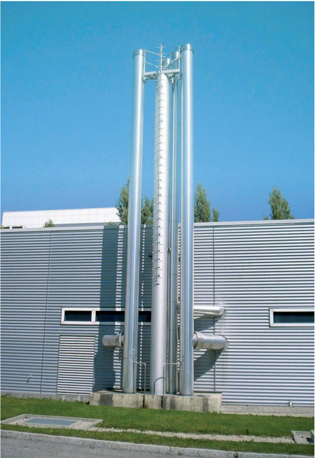
Bild 6: Luft- und Abgasschornstein (Foto: Ruhland GmbH, Ampfing)
