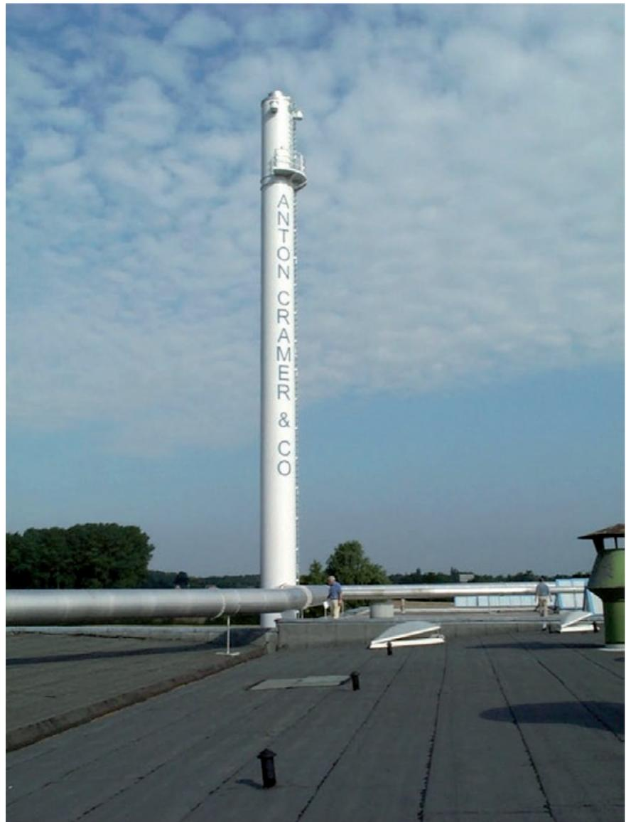
Bild 7: Schornstein mit Schwingungsdämpfer und Verbindungsleitung (Foto: Monotal Schornsteinbau und Wartung GmbH, Nordhorn)
