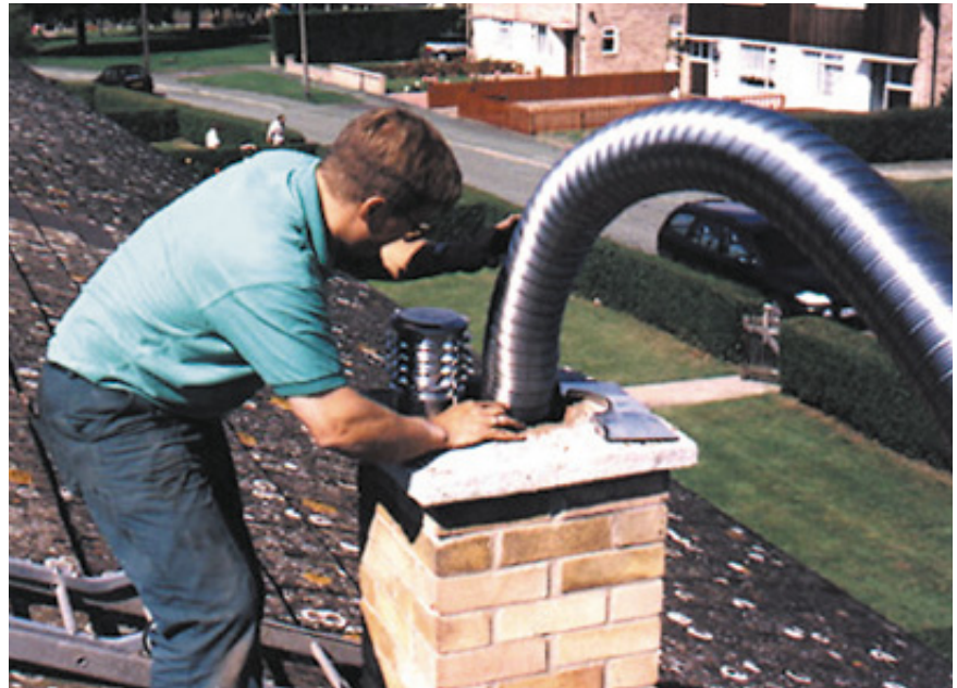
Bild 7: Flexible Rohre aus Edelstahl Rostfrei lassen sich schnell, kostengünstig und ergebnissicher über die Mündung der Abgasanlage einbauen
