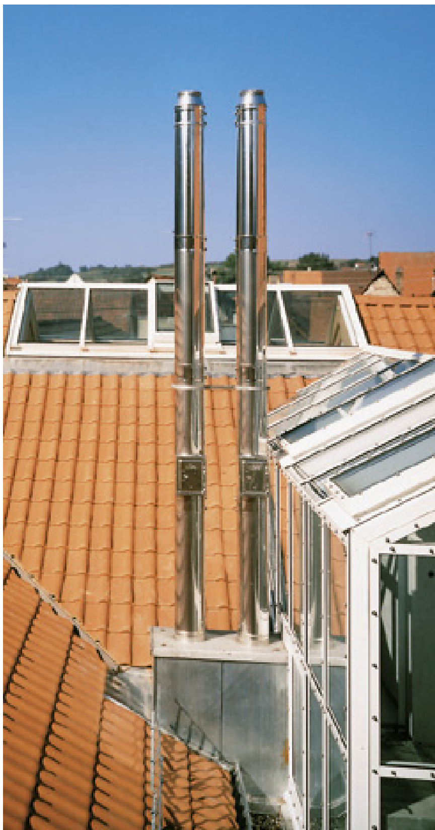
Bild 10: Wenn Abgasanlagen erhöht werden müssen, ist die Schornsteinkopfverlängerung mit vorgefertigten Systemelementen aus Edelstahl Rostfrei eine kostengünstige Lösung
