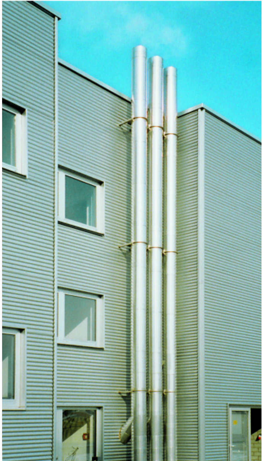
Bild 14: Abgasanlagen aus Edelstahl Rostfrei sind kostengünstig in Montage und Betrieb und sehen auch an der Außenwand eines Gebäudes gut aus
