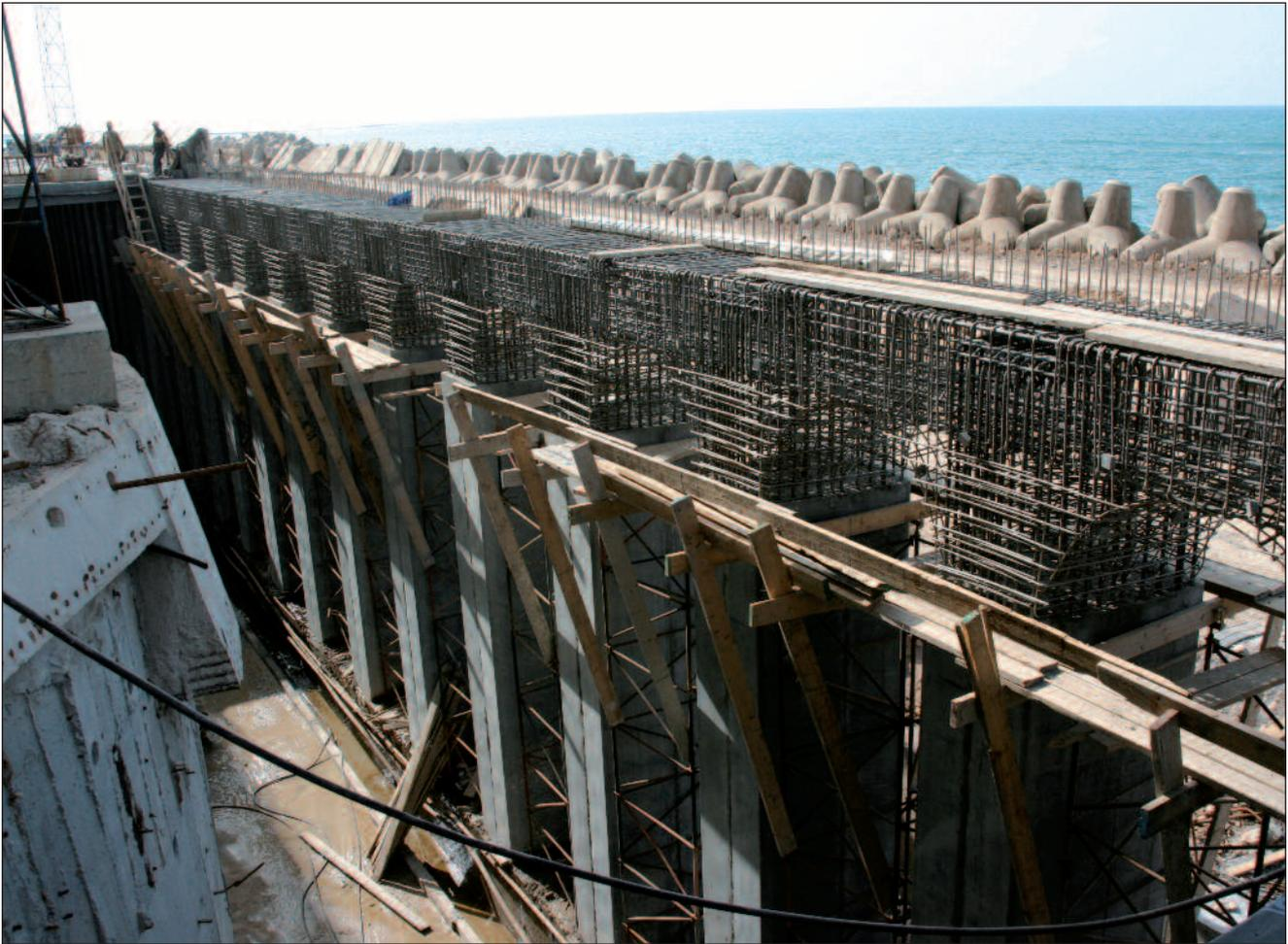
Bild 9: Nichtrostende Betonbewehrung in durch salzhaltige Luft und Dünung belasteten Außenwänden und Stützfeilern der Moschee König Hassan II. in Casablanca (Marokko)
