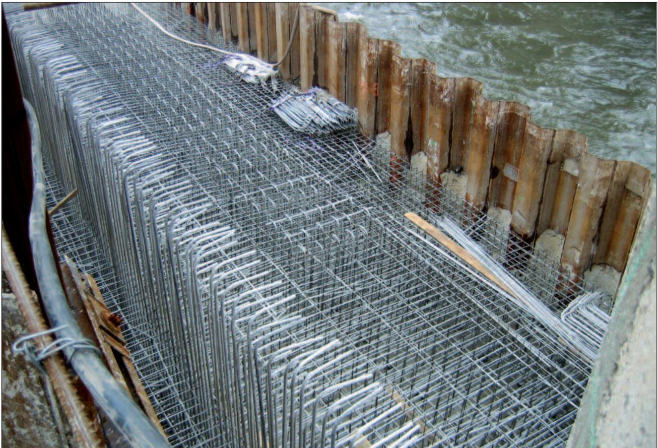
Bild 12: Nichtrostende Bewehrung einer Stütz wand zur Uferbefestigung eines Flusses in Tschechien
