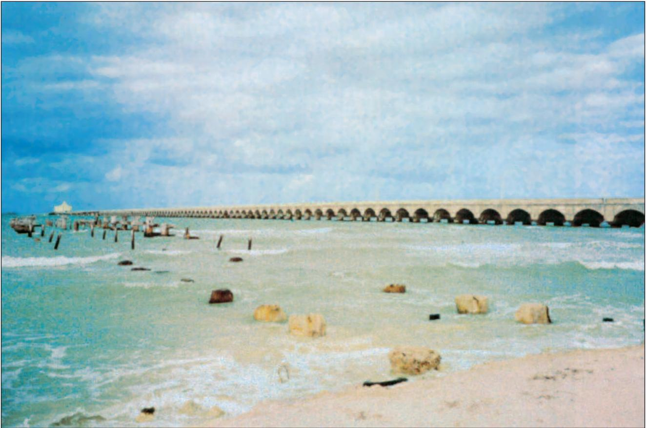
Bild 10: Landebrücken aus Stahlbeton in Progreso (Mexiko, Yucatan Halbinsel) [25]; rechte Landungsbrücke nach 60 Jahren mit nichtrostendem Betonstahl bewehrt; linke Landungsbrücke nach ca. 35 Jahren mit unlegiertem Betonstahl bewehrt
