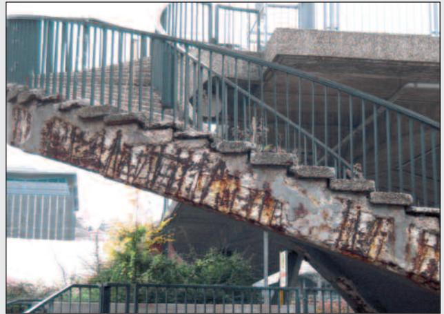
**Hohe Korrosionsbeanspruchung:** Die Bewehrung einer Stützwand bzw. Treppe korrodierte als Folge einer Tausalzbeanspruchung. Die Folge sind Stahlabtrag, Bildung voluminöser Korrosionsprodukte und Betonabspaltung. Die Anwendung zusätzlicher Korrosionsschutzmaßnahmen kann diese Schäden verhindern.
