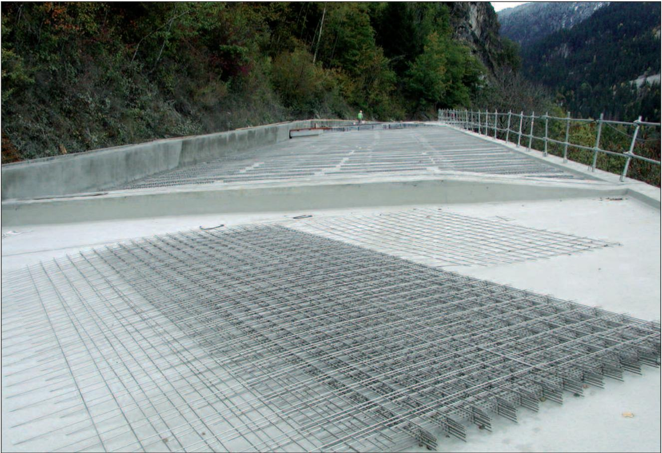
Bild 11: Nichtrostende Betonstahlmatten in einer Lawinenschutz-Konstruktion in Frankreich
