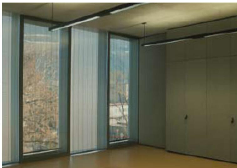
*Der Sonnenschutz ist im Wechsel vor und hinter den Glaselementen angebracht und bietet bei hohem Blendschutz eine direkte Sichtverbindung mit der Umgebung.*
