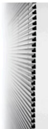
*Die spezielle Profilierung der Edelstahl lamellen ermöglicht ein Optimum zwischen Energiereduzierung und Kontakt zur Außenwelt.*
