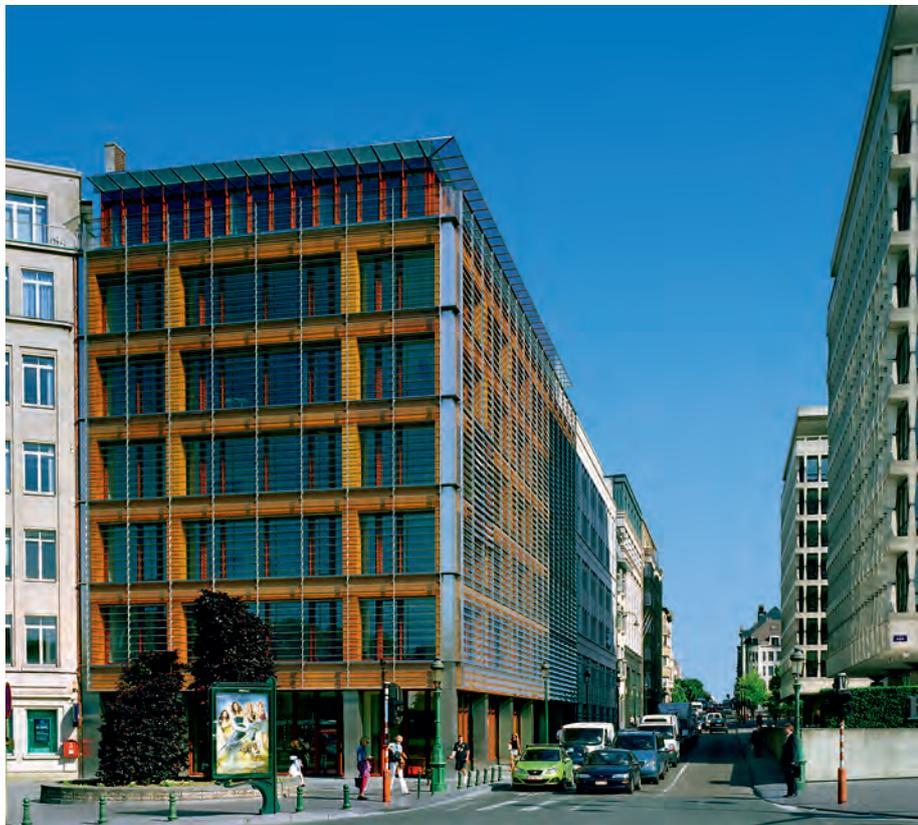
*La résistance mécanique élevée de l'acier inoxydable (EN 1.4301) permet une construction extrêmement mince de la façade en verre avec des profilés de 100 mm x 12 mm.*
