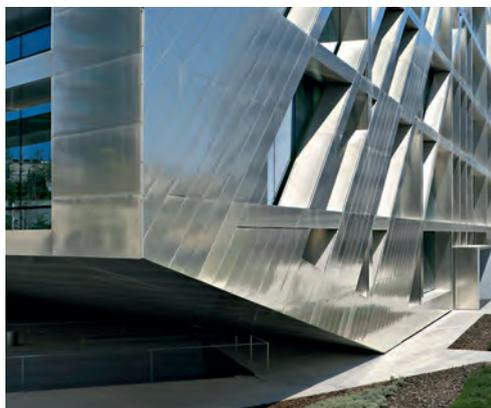
*La structure de façade recouverte de panneaux en acier inoxydable horizontaux, verticaux et diagonaux enveloppe tout le bâti vitré.*
