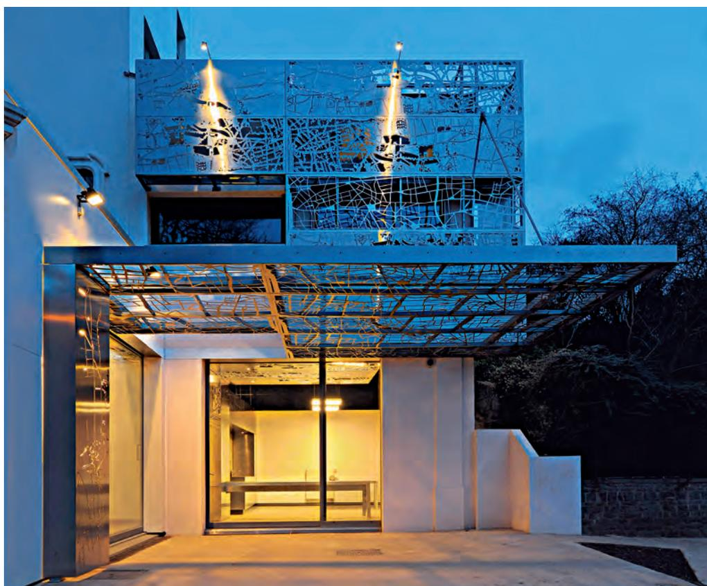
*Les panneaux métalliques découpés au laser permettent des variations et des degrés de transparence à l'infini en fonction du choix de la carte géographique utilisée comme modèle.*
