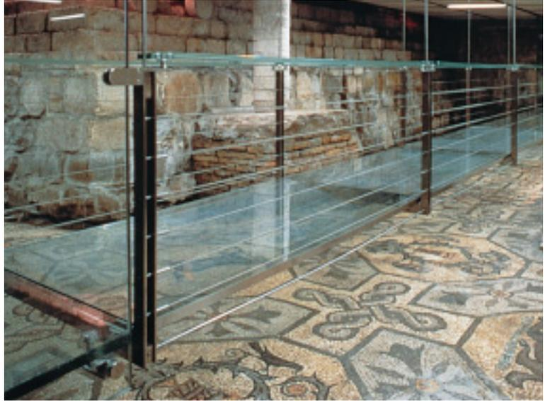
*Vertikale Glasscheiben an den Ecken verhindern in Kombination mit seitlich verlaufenden horizontalen Spannstäben einen möglichen Pendel-effekt der angehängten Konstruktion.*
