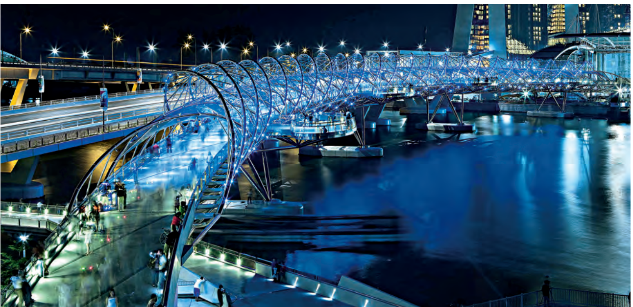
Energieeffiziente LEDs in den Spiralrohren betonen die Struktur der „Helix“ und sorgen für stimmungsvolle Inszenierungen bei Nacht.
