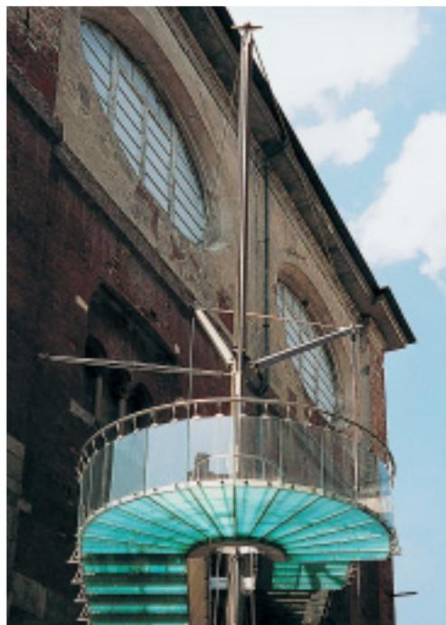
*Die Stütze verzweigt sich im Knotenpunkt in drei "Finger", an denen das Stufengerüst aufgehängt ist.*
