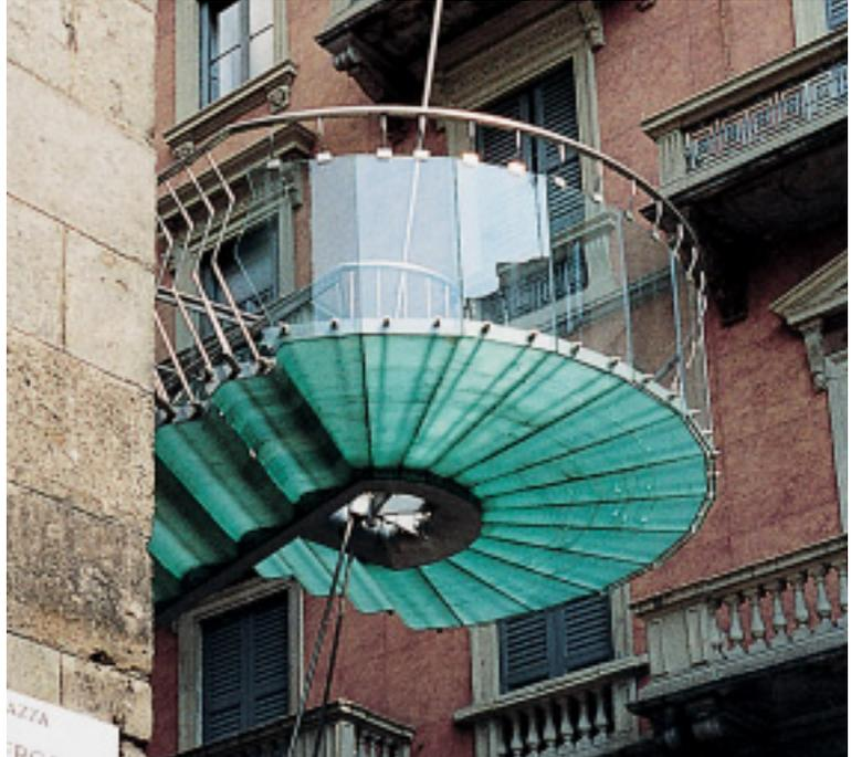
*Der über 26 m lange Treppenlauf ist nur an drei Punkten – jeweils auf Höhe der Podeste – über die Hängestäbe mit der tragenden Stütze verbunden.*
