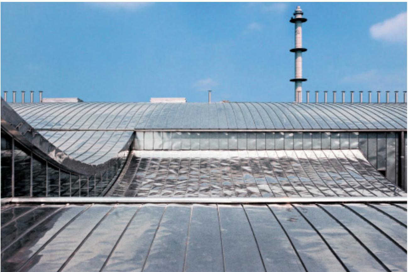
Même si à l'origine, inspiré par d'autres modèles de bâtiment du campus, le choix du matériau pour les façades et les toits s'était porté sur le cuivre, l'acier inoxydable a fini par l'emporter. Coûts réduits, longévité, résistance à la corrosion et image « high tech » entre autres, ont largement fait pencher la balance en faveur de l'« inox ». Les détails déjà mis au point pour la couverture de cuivre ont donc pu être réutilisés quasi tels quels.
