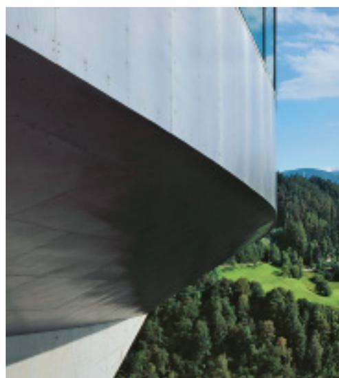
*Les tôles fortes en acier inoxydable d'1 mm d'épaisseur sont fixées à l'aide de rivets aveugles à la structure porteuse.*
