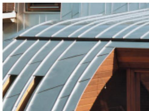
Des jardins d'hiver vitrés situés au Nord, revêtus de bois ou de tuiles, offrent un accès aux logements à l'abri des intempéries. Les grandes toitures et façades en joint debout sont orientés Sud/Sud-Ouest.
