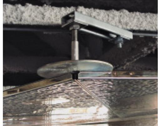
*Das eigens entwickelte Befestigungssystem ermöglicht eine flexible Aufnahme der Paneele.*
