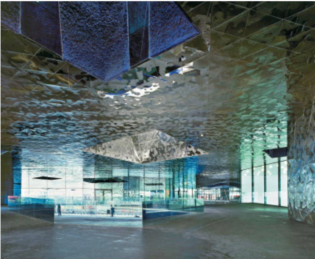
*Die Deckenuntersicht des großen, blauen Baukörpers besteht aus Edelstahlpaneelen, deren Prägemuster einer spiegelnden Wasseroberfläche nachgebildet ist.*
