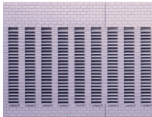
Die klare Architektursprache ist von den geschosshohen Raumöffnungen im Erdgeschoss und den über Eck geführten, senkrechten Lüftungsschlitzen mit ihren waagrecht Edelstahllamellen geprägt. Die gesamte Fassadenkonstruktion musste dem enormen Schalldruck von Innen nach Außen standhalten, einschließlich der Be- und Entlüftungsanlage. Die Lüftungsschlitze mit den Edelstahllamellen sind daher schallgedämmt.
