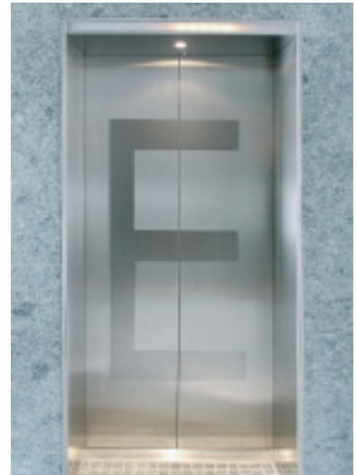
Durch das Strahlen mit Glasperlen zeichnet sich auf der blankgewalzten Edelstahloberfläche (2R) dieser Aufzugstür die Etagenbezeichnung matt ab.
