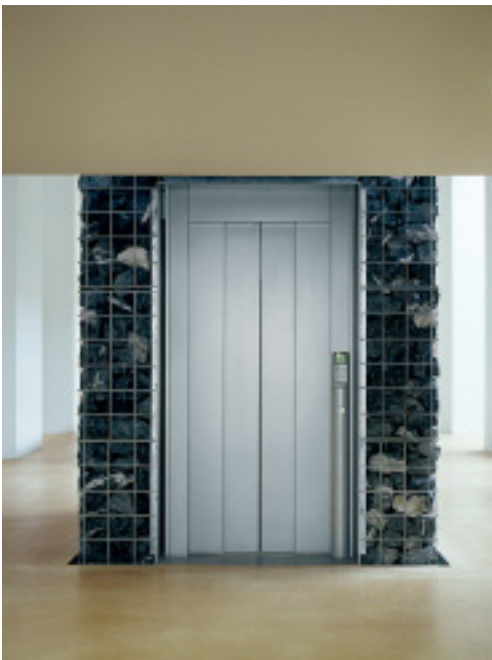
Die Kabinenverkleidung aus mustergewalztem Edelstahlblech (2W) in der Fachhochschule Vaduz harmoniert mit dem umgebenden Aufzugsschacht aus geschichteten Bruchsteinmaterial.
