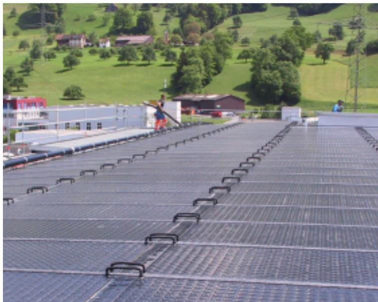
*Die unverglasten, selektiv mit Schwarzchrom beschichteten Absorber zeichnen sich durch minimale Abstrahlungsverluste aus.*
