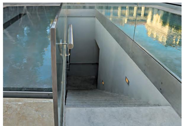
und polierte bis hin zu mustergewalzten Oberflächen. Allen Ausführungen gemein ist eine unsichtbare, nur wenige Atomlagen dicke Oxidschicht auf der Oberfläche des nichtrostenden Stahls. Da sich diese sogenannte Passivschicht bei Beschädigungen unter dem Einfluß von Sauerstoff aus Luft oder Wasser immer wieder neu bildet, ist ein weiterer Korrosionsschutz, wie zum Beispiel eine Beschichtung, nicht notwendig.
