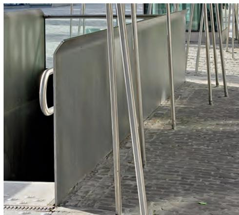
*Die Brüstungen der Treppenabgänge bestehen aus 12 mm dicken nichtrostenden Stahlblechen, die durch eine Abkantung im oberen Bereich zusätzlich ausgesteift werden.*
