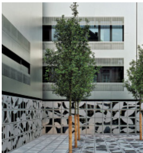
Die Sonnenschutz- elemente sind bewegliche Teile der Edelstahlhaut, die bündig zur Fassade schließen.
