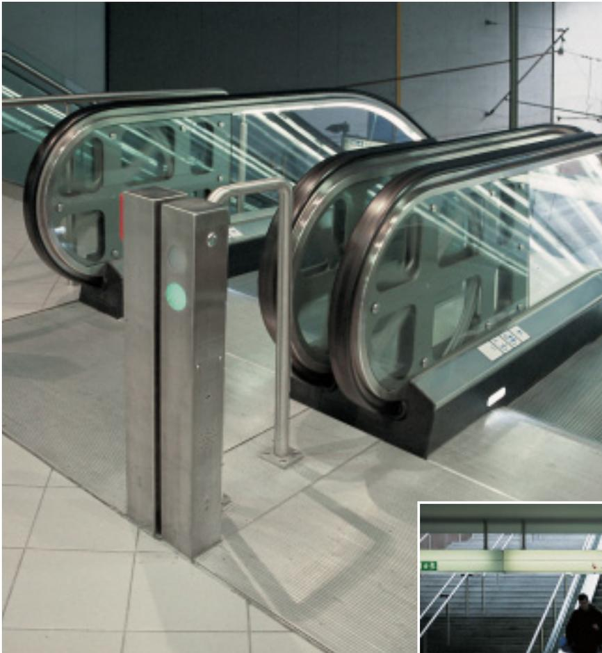
Bei Fahrtreppen und -bändern ist der Einsatz von Edelstahl Rostfrei nicht mehr wegzudenken. Sockel- und Balustradenverkleidungen mit geschliffenen oder gebürsteten Oberflächen, strukturgeätzte Platten im Antrittsbereich und nicht zuletzt das Stufenband selbst sind zu selbstverständlichen Bestandteilen öffentlichen Lebens geworden.
