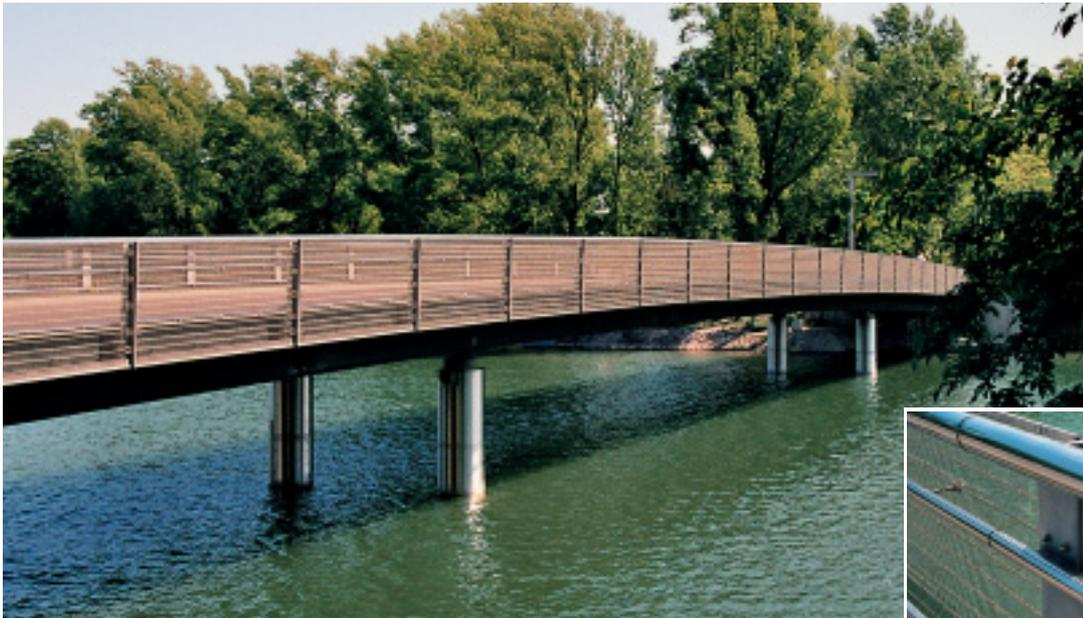
**Die Geländer der sanierten Brücke bestehen aus Edelstahl-Profilen und -Gewebe.**
