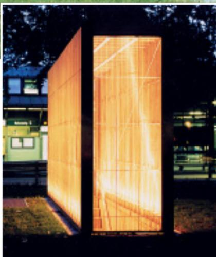
**Die innenliegende Beleuchtung läßt das mit Edeltstahlgewebe bekleidete Bauwerk nachts erstrahlen.**
