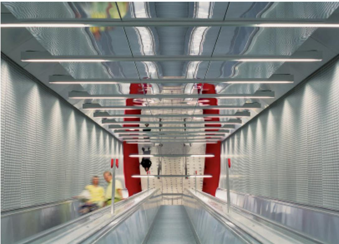
**Die spiegelpolierte Deckenverkleidung aus Edelstahl weitet den engen Rolltreppenabgang.**
