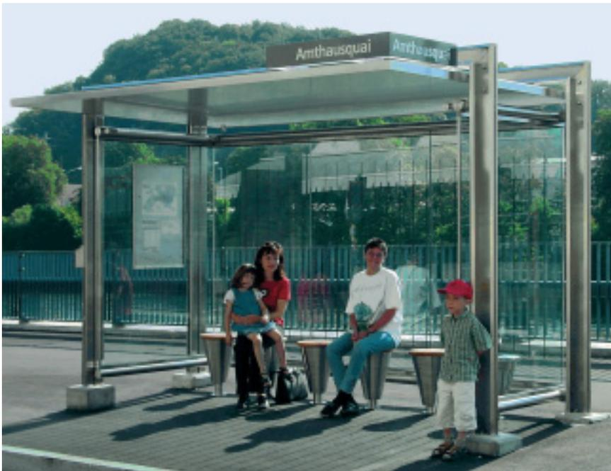
Das neue Wartehäuschen am Amthausquai im schweizerischen Olten zeichnet sich durch modular einsetzbare Bauteile aus. Sie sind aus Edelstahl gefertigt und können je nach Bedarf individuell dimensioniert werden. Auch das Zubehör wie Sitzgelegenheiten, Abfallbehälter sowie die Fahrplankarten sind in Edelstahl ausgeführt und können ganz nach Wunsch eingesetzt werden.
