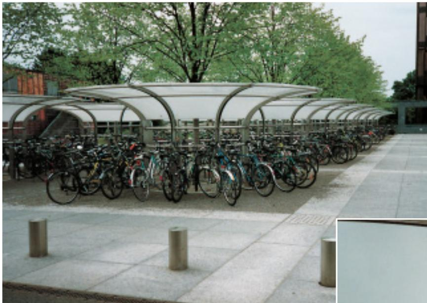
Auf dem Campusgelände Höggerberg der ETH Zürich steht diese gestalterisch anspruchsvolle und gut funktionierende Abstellanlage für die zahlreichen Fahrräder der Studenten. Eine Tragkonstruktion aus Edelstahl-Profilen mit darauf befestigten, transluzenten Kunststoffplatten wölbt sich schützend über die geparkten Fahrräder.
