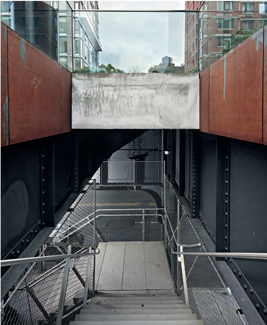
Transparente Geländerfüllungen und Absturzsicherungen aus rostfreien Drahtseilnetzen an den Treppenaufgängen zum High Line Park harmonieren perfekt mit alten genieteten Stahlkonstruktionen.
