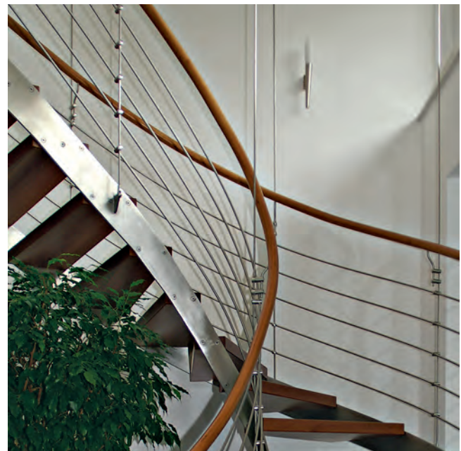
Die zusätzliche Abhängung der gewendelten Wangentreppe ermöglicht eine äußerst schlanke Konstruktion.
