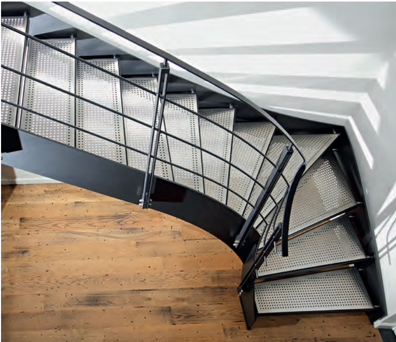
Eine sorgfältige Detaillierung zeichnet die viertelgewendelte Wangentreppe in einem Wohnhaus aus. Die in Stahlrahmen eingelegten Bleche aus Edelstahl rostfrei sind mit einer Quadratlochung versehen.
