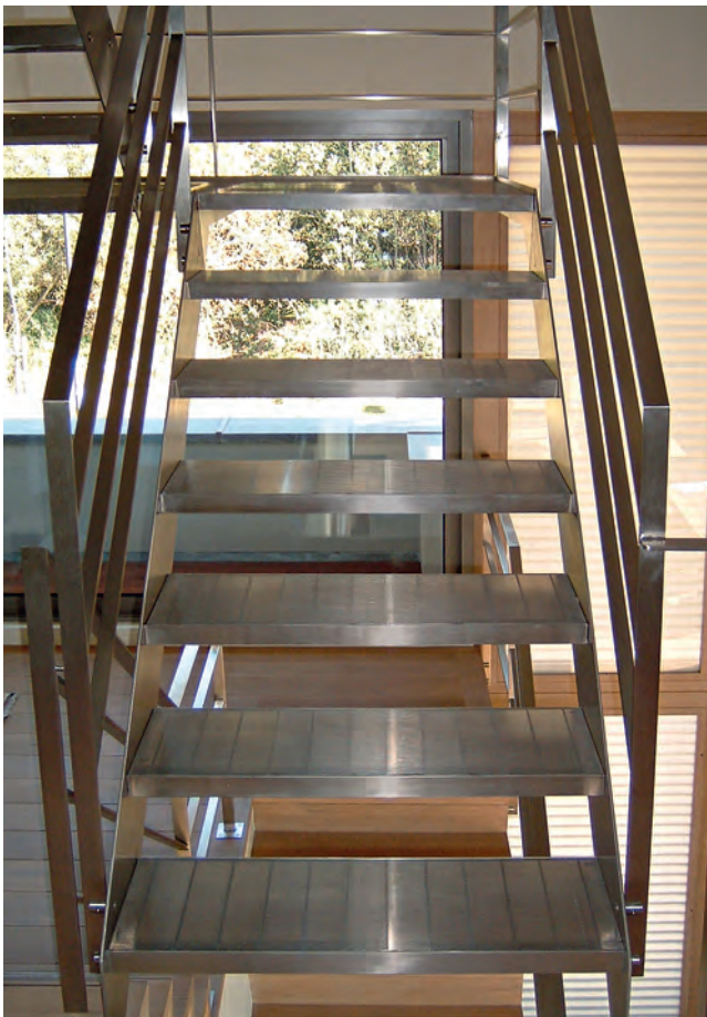
Wangen und Geländer aus rostfreiem Flachstahl mit geschliffener Oberfläche und Trittstufen mit Designgittern verleihen der Treppe ihre elegante Ausstrahlung.
