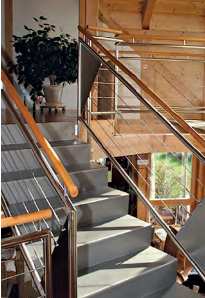
Das matts Erscheinungsbild der faltwerkterppe aus nichtrostenden Stahlblechen entsteht durch Glasperlstrahlen der Oberfläche.
