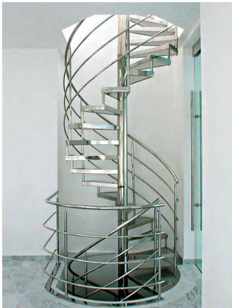
Sämtliche Oberflächen der in Edelstahl rostfrei ausgeführten Spindeltreppe sind poliert.
