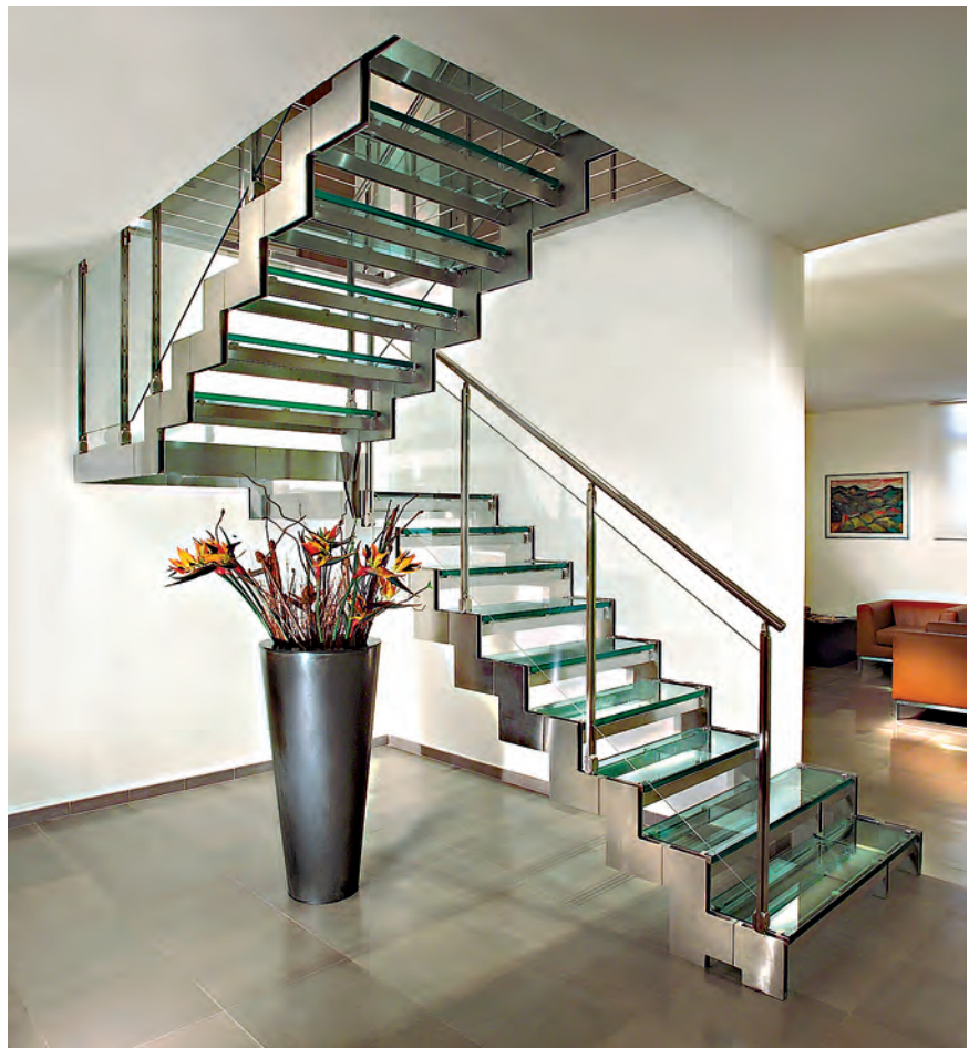
Bei diesem Treppensystem aus nichtrostendem Stahl und Glas sind selbst die tragenden Wangen aus Einzelelementen zusammengesetzt.
