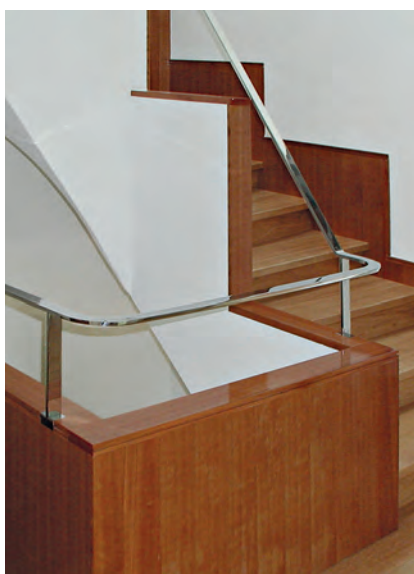
Der schlichte, hochglanzpolierte Handlauf aus Edelstahl Rostfrei verleiht dem Treppenhaus seine besondere Eleganz.
