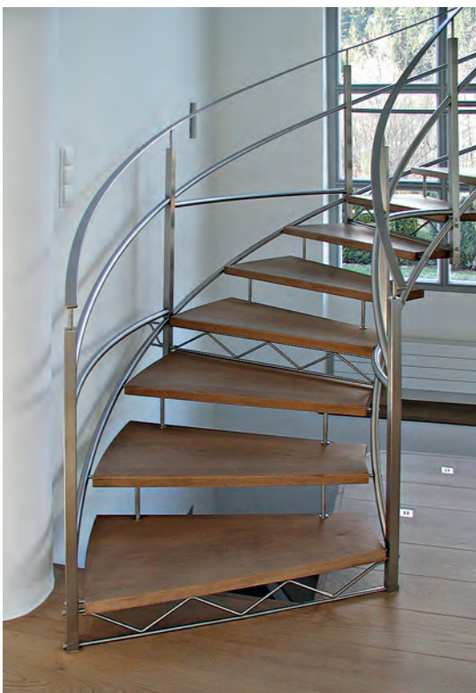
Das komplexe Tragsystem der filigranen Wendeltreppe mit hölzernen Trittstufen setzt sich aus unterschiedlichen nichtrostenden Stahlprofilen zusammen.
