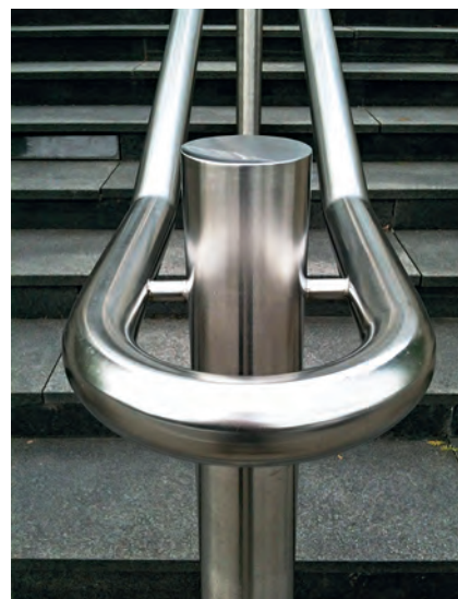
Durch sorgfältige Nachbearbeitung wirkt die Oberfläche des geschweißten Handlaufs wie „aus einem Guss“.
