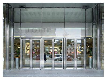
Klar gegliedert und silbrig glänzend verleiht die wärmegedämmte Pfosten-Riegel-Fassade mit zurückversetzten Eingangstüren dem Kaufhaus sein hochwertiges Erscheinungsbild.
