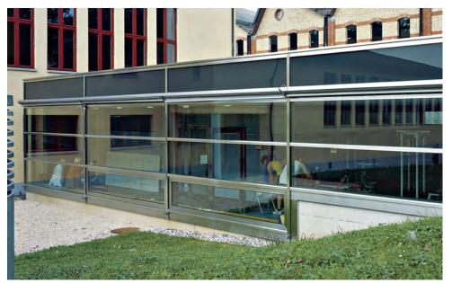
Auch als Pfosten-Riegel-Fassade punktet der elegante, wartungsarme Werkstoff: Die schmalen, wärmegedämmten Profile lassen den Anbau leicht und zurückhaltend wirken. Der Charakter des umgebenden Ensembles bleibt gewahrt.
