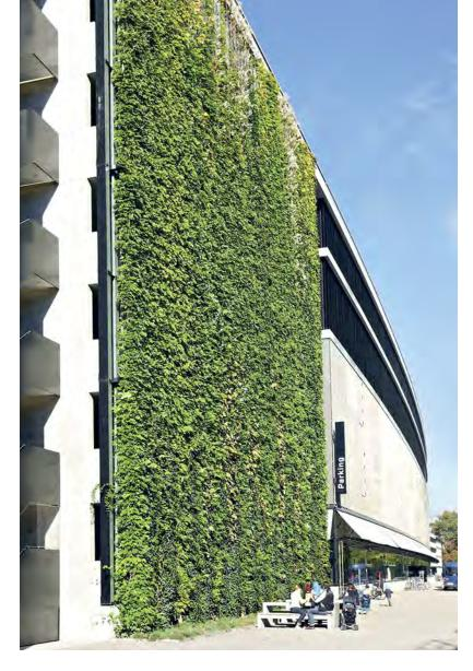
Begrünte Fassaden erfreuen sich zunehmender Beliebtheit: Besonders in Großstädten tragen sie entscheidend zur Verbesserung der Luftund Lebensqualität bei. Seilsysteme aus nichtrostendem Stahl halten dauerhaft den stetig zunehmenden Lasten der wachsenden Pflanzen stand.
