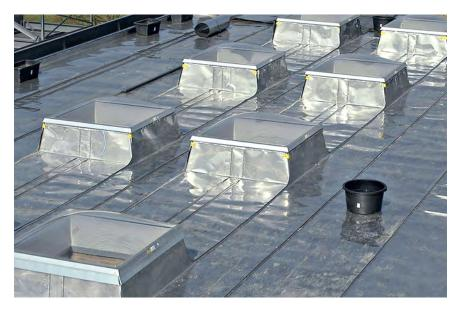
Die walzblanken, rollennahtgeschweißten Bleche sind nach Fertigstellung des Flachdaches größtenteils unter einer Kiesschicht oder Dachbegrünung verborgen.
