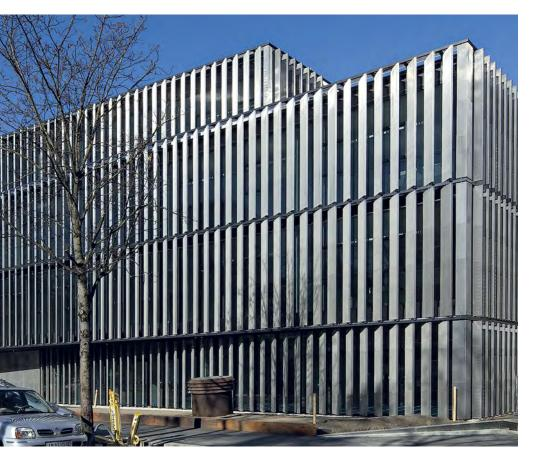
Vor der gläsernen Fassade sorgen individuell bedienbare, leicht reflektierende Lamellen mit Edelstahlgewebe für Sonnen- und Sichtschutz. Erst bei Dunkelheit lässt das durchschimmernde Kunstlicht die dahinterliegende Gebäudestruktur sichtbar werden.
