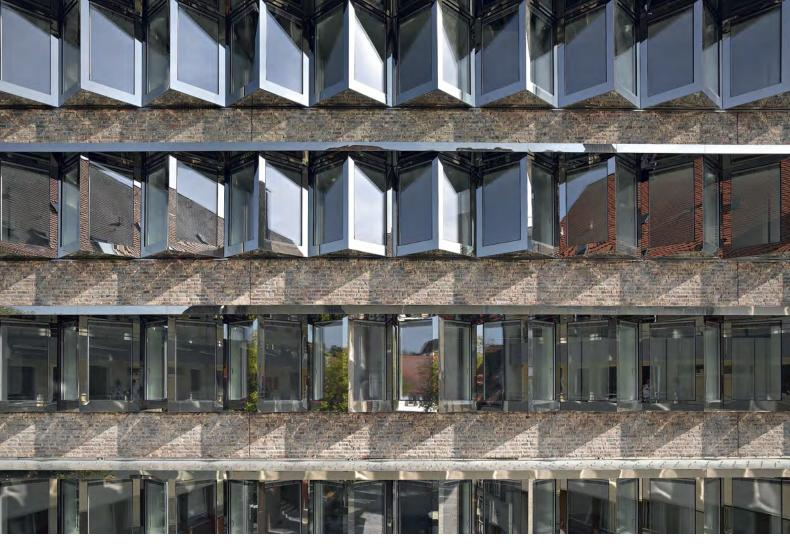
An der Fassade der Sparkasse Ulm wechseln sich in Zick-Zack-Form gefaltete Fensterbänder mit polierten Edelstahlrahmen und Mauerwerk aus alten Ziegeln ab. So fügt sich der Neubau beispielhaft in die historische Umgebung ein und bringt gleichzeitig seine Modernität zum Ausdruck.
