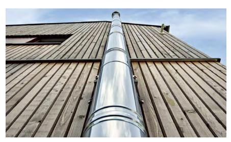
Abgesehen von ihrer eigentlichen Funktion werden Abgasanlagen aus Edelstahl Rostfrei als architektonisches Gestaltungselement im Innenraum und an der Fassade eingesetzt.
