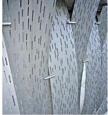
Die matt gestrahlten Edelstahlbleche mit unregelmäßigen, lasergeschnittenen Schlitzen bilden einen lichtdurchlässigen Sichtschutz. Die gebogenen Elemente steifen sich gegenseitig über Rundstäbe aus und verleihen der Konstruktion zusätzliche Tiefe.
