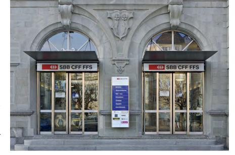
Schlanke Türprofile und Vordächer kennzeichnen den Eingang in den Bahnhof. Das massive Natursteinmauerwerk und die Edelstahl-Glas-Konstruktion zeugen von ihrer jeweiligen Entstehungszeit und bilden miteinander ein harmonisches Ganzes.
