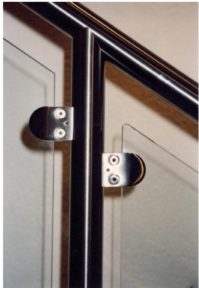
Bild 7: Leicht lösbare Verbindungen erhöhen die Wiederverwendungsfähigkeit von Bauteilen aus Edelstahl Rostfrei (Foto: Schlosserei Singler GmbH, Griesheim)
