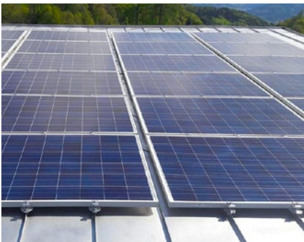
Solarpaneele können auch ohne Modulträger direkt an den Doppelstehfalzen von Uginox-gedeckten Dächern befestigt werden (© Rooftech GmbH)
