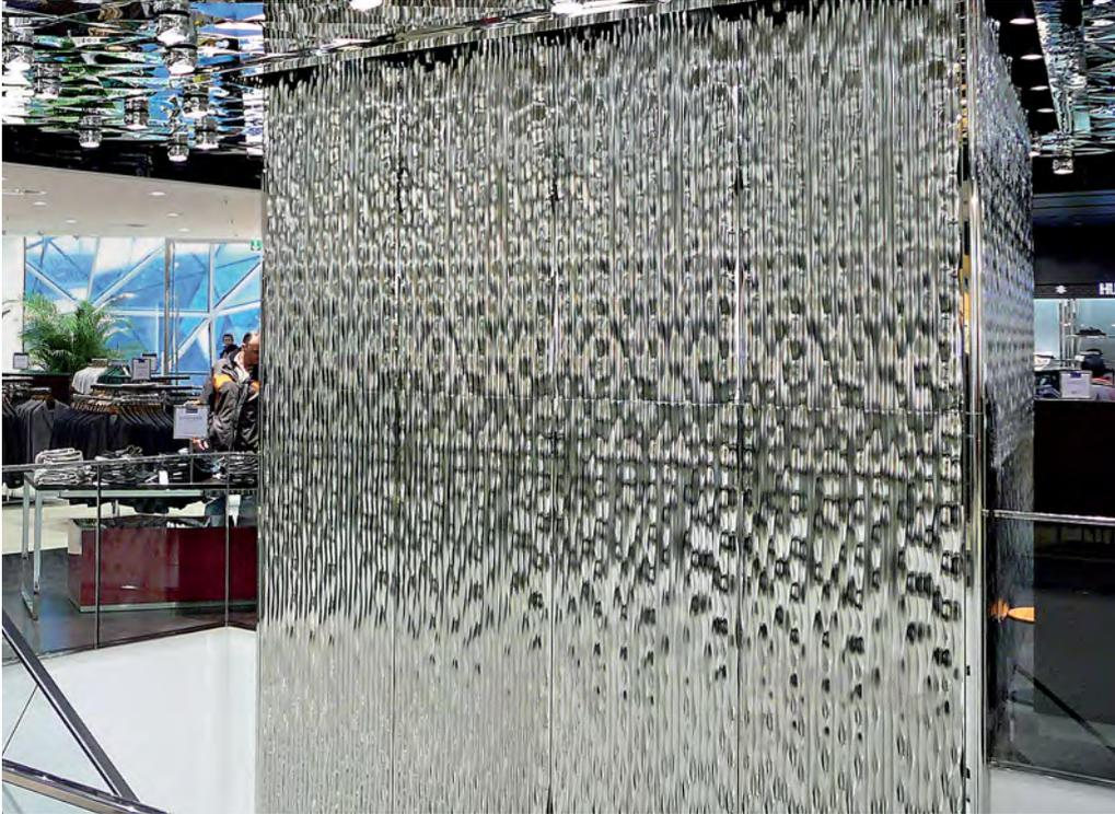
*Die kaltverformten Edelstahlbleche konnten in nur einem Arbeitsgang gefertigt werden.*
