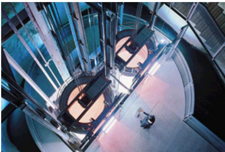
*Die Liftkonstruktion ist im Bereich der Ausstiegsebenen verglast. Ansonsten besteht sie aus einer offenen Stahlkonstruktion.*
