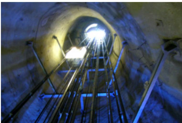
Die beiden Edelstahl-Liftkabinen sind mit opakem Plexiglas umkleidet. Zwischen der Edelstahlverkleidung im Inneren und der äußeren Plexiglasschicht sind Leuchtstoffröhren montiert, so dass die Kabinen im Berg wie auf- und abgleitende Leuchtkörper erscheinen. Der Werkstoff Edelstahl Rostfrei stellt einen interessanten Kontrast zum groben, rauen Schachttinneren her und hält gleichzeitig der Feuchtigkeit im Berginneren stand.
