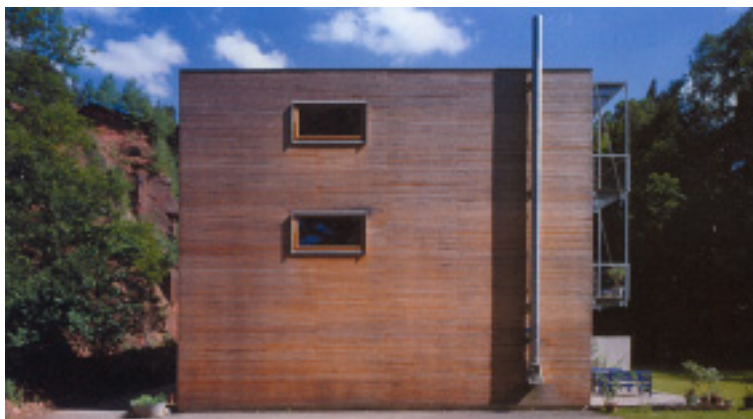
Bauherrengemeinschaft Busch, Dujmovic, Ruland, Schanné, Schon, Kaiserslautern, Deutschland Architekt: AV 1 Architekten, Kaiserslautern, Deutschland Fotos: Michael Heinrich, München, Deutschland
