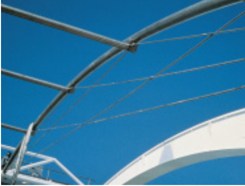
Montage des Tragwerks aus Edelstahl Rostfrei- Rohren zwischen den auskragenden Kasten- trägern
