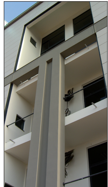
▲ Detailsicht T-Element und Plattenelement. Bild: 31c90684.tif
