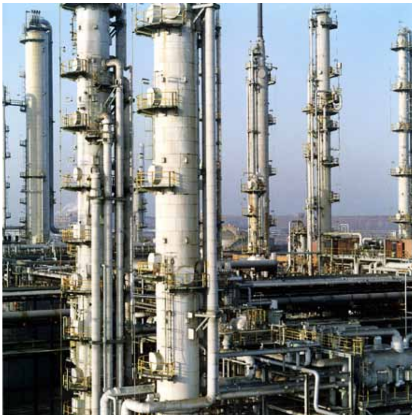
Treibende Kraft bei der Erfindung von Edelstahl war die chemische Industrie : Destillationskolonnen aus rost-, säure- und hitzebeständigem Edelstahl. (Foto: ThyssenKrupp Nirosta)
