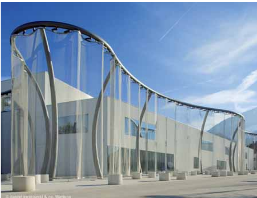
Das innovative Edelstahl-Drahtringgeflecht trägt als optisch überzeugende Hülle zur Verbesserung des Raumklimas bei (Daniel Swarovski & Co. Wattens).
