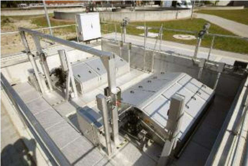
**Bild 5: Abwasserbehandlungsanlage aus Edelstahl Rostfrei zum Abscheiden feinsten Feststoffe (Foto: Huber SE, Berching)**
