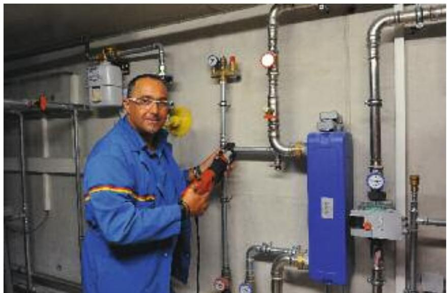
**Bild 4:** Trinkwasserinstallation und Warmwasserbereitung mit Rohren und Pressfittings aus Edelstahl Rostfrei (Foto: Esta Rohr GmbH, Siegen / Installationsunternehmen Siegfried Bruni)
