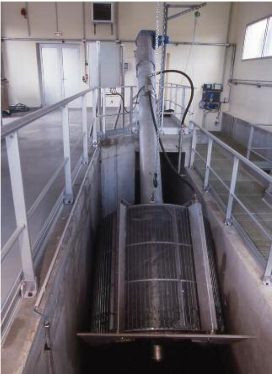
**Bild 6: Siebanlage aus Edelstahl Rostfrei zur Abwasseraufbereitung in einer Kläranlage (Foto: Ugitech GmbH, Renningen / Ondeo IS, Paris la Défense(F))**
