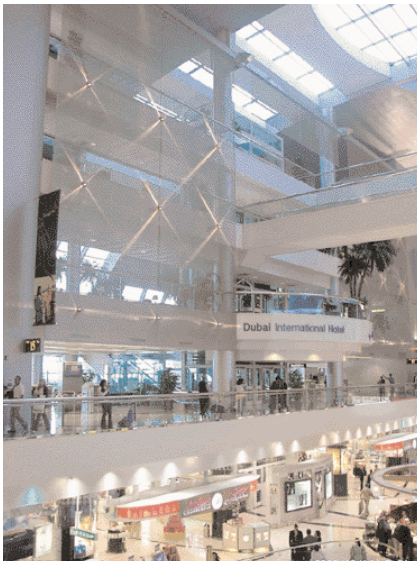
Fassadenverkleidung im Dubai International Airport mit Edelstahl-Drahtgewebe (Foto: GKD-Gebr. Kufferath AG, Düren)
