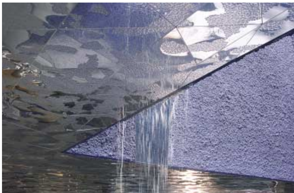
Spannende Illusion einer Wasserspiegelung durch 28.000 individuell geprägte Edelstahl-Dreieck-Elemente
