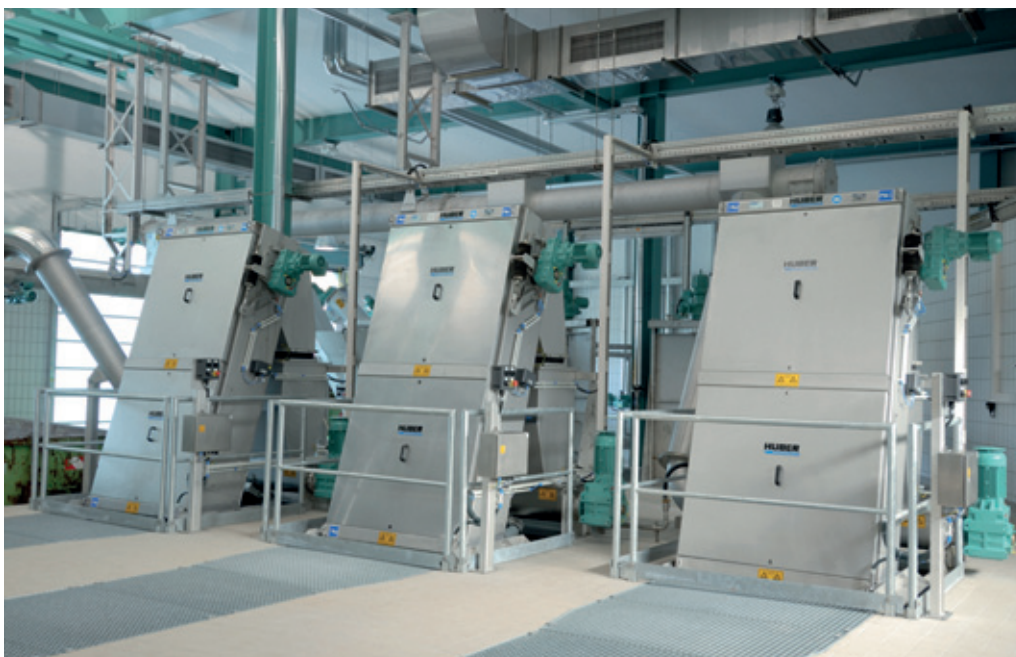
Multi-rake bar screens Photo: Hans Huber, Berching (D)
