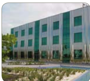
Nuance 1.4521/444 n° 4 brossée (plaques horizontales), Vivo Building, Rio De Janeiro, Nucleo Inox, Brésil (environnement côtier)
