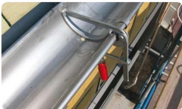
Fixation de gouttière en 430Ti revêtu d'étain.
