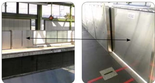
Barrière de sécurité - quai de gare en SUS430 J/L, Japon.
