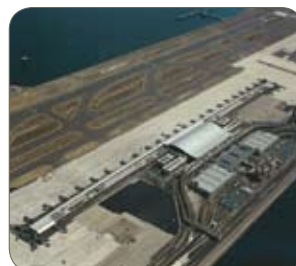
Nuance SUS447J1, terminal de l'aéroport de Kansai (architecte : Renzo Piano), JSSA, Osaka, Japon
