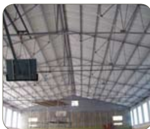
Charpente : une application potentielle pour les ferritiques
