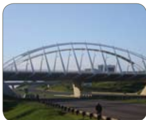
Nuance 1.4003/410 peinte, SASSDA, Afrique du Sud (pont en service depuis plus de huit ans).
