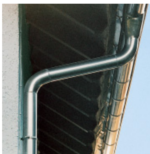
Gouttière et tuyau de descente avec finitions d'usine standard : brillante 2B (à droite) et mate 2D (à gauche)
