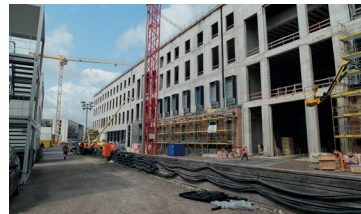
Bild 2: Fassadenabschnitt. Bild: 31C00792
