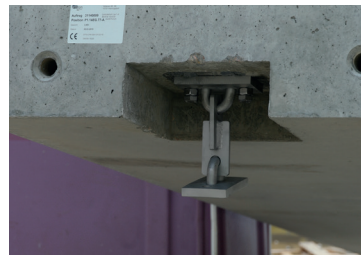
Bild 3: Fertigteilbefestigung mit Doppelgelenkankern. Bild: 31C00791
