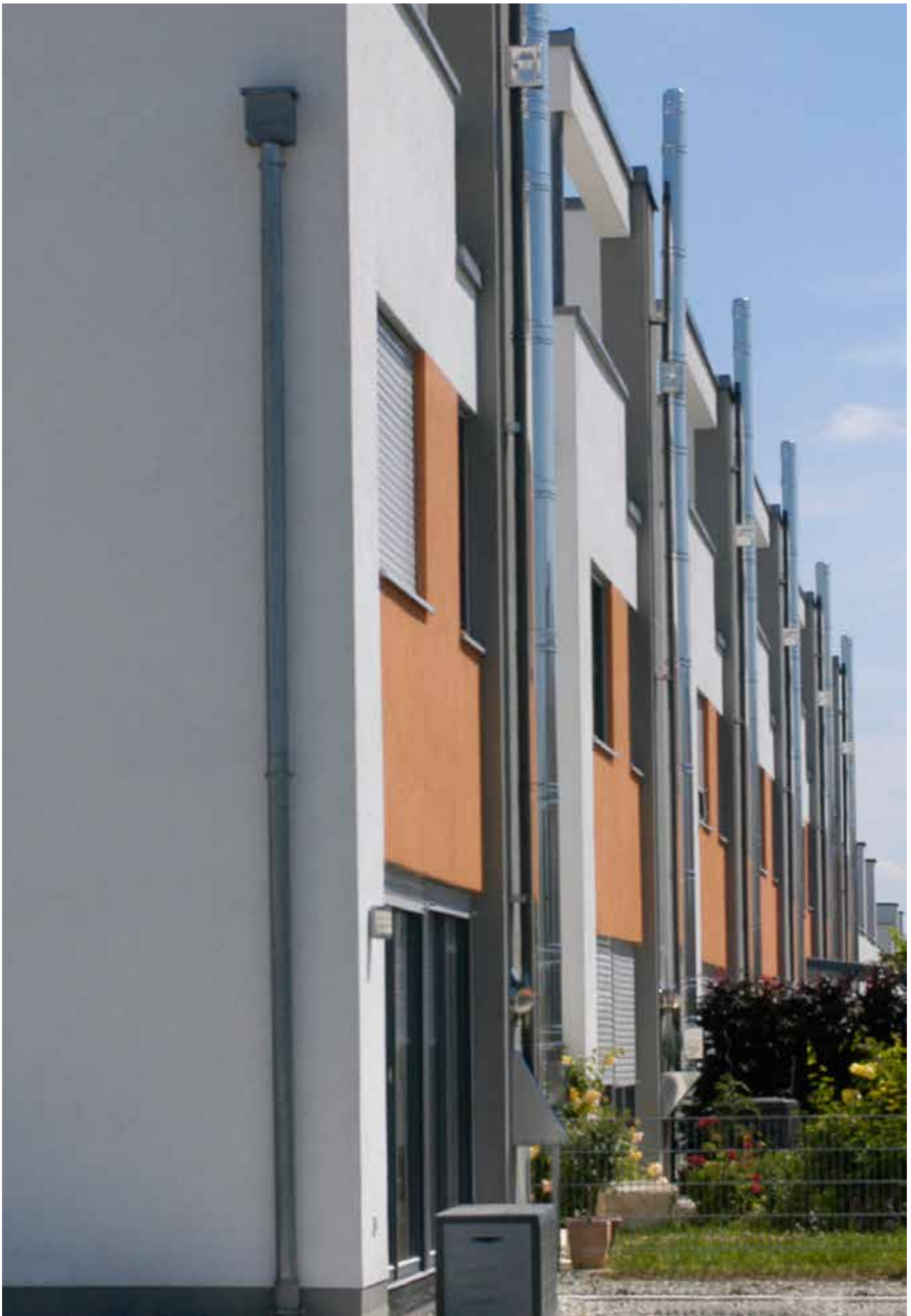
Bild 14: Abgasanlagen aus Edelstahl Rostfrei sind kostengünstig in Montage und Betrieb und sehen auch an der Außenwand eines Gebäudes gut aus
