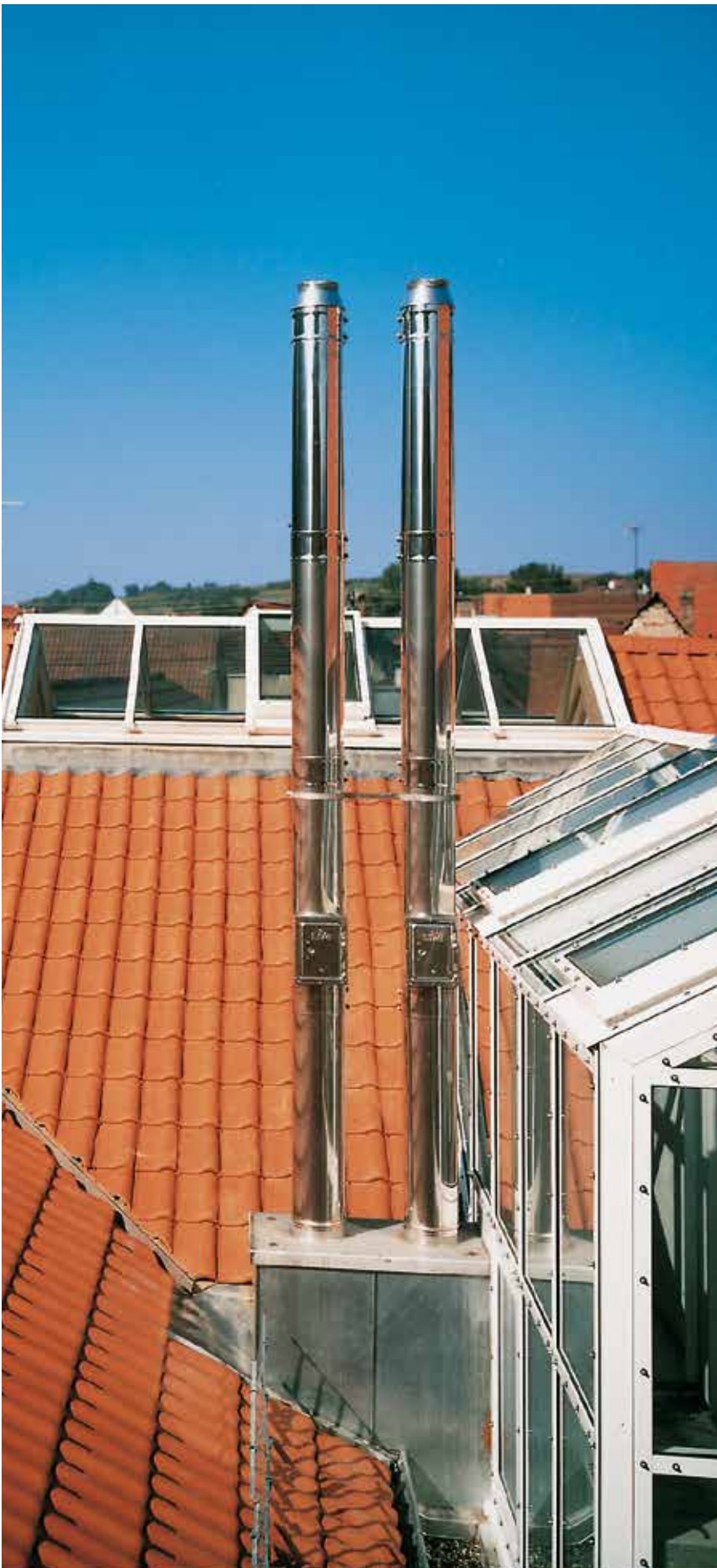
Bild 10: Wenn Abgasanlagen erhöht werden müssen, ist die Schornsteinkopfverlängerung mit vorgefertigten Systemelementen aus Edelstahl Rostfrei eine kostengünstige Lösung
