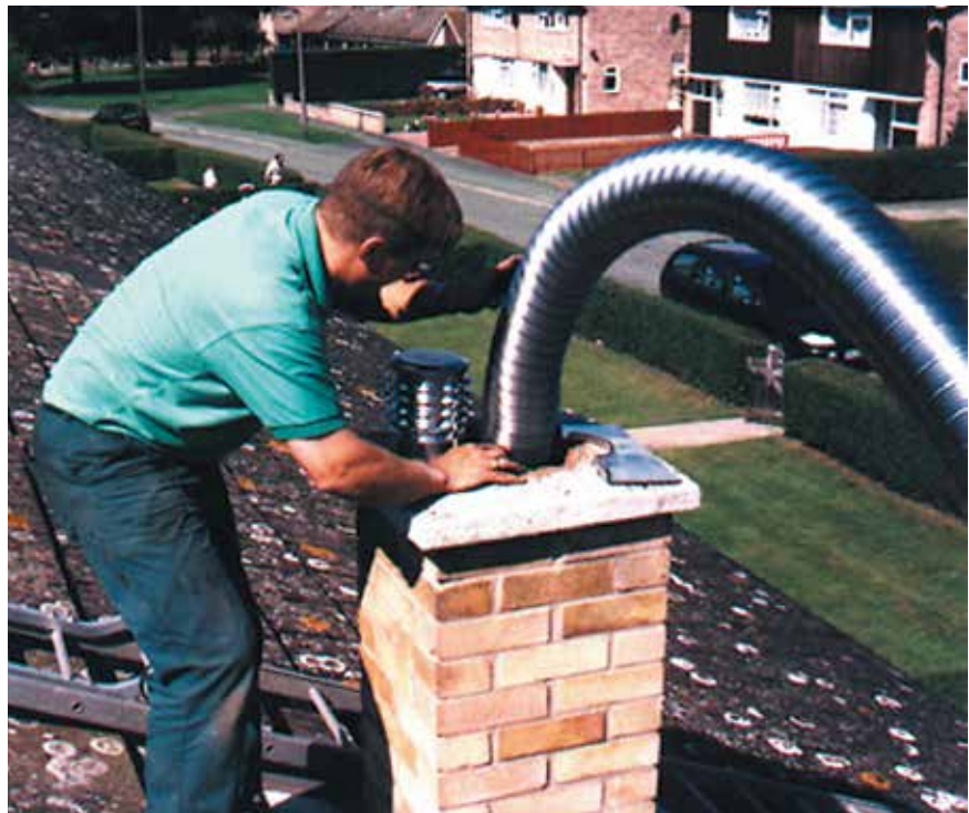
Bild 7: Flexible Rohre aus Edelstahl Rostfrei lassen sich schnell, kostengünstig und ergebnissicher über die Mündung der Abgasanlage einbauen
