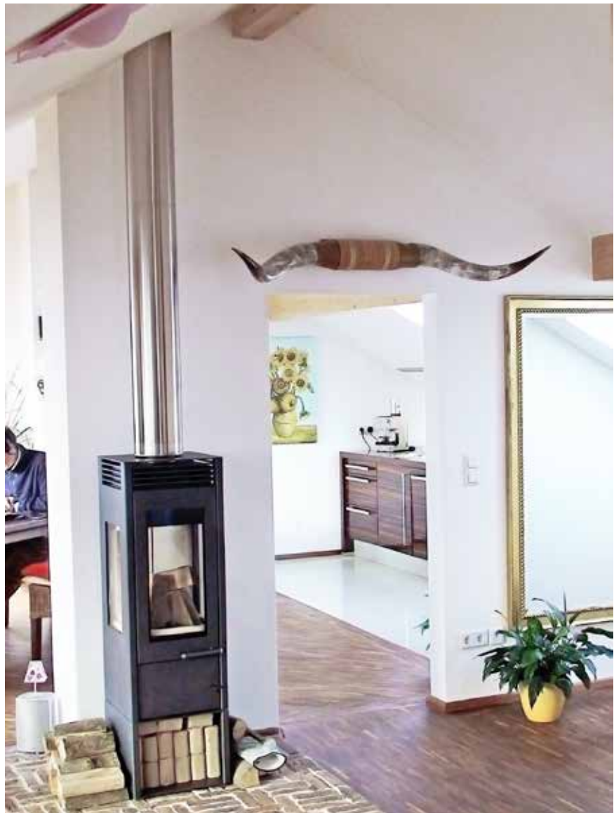
Bild 3: Abgasanlage aus Edelstahl Rostfrei in einem Innenraum – auch ein dekoratives Element
