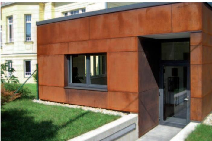
Abb. 32: Wohngebäude-Erweiterung mit geklebten Fassadenblechen aus wetterfestem Baustahl
