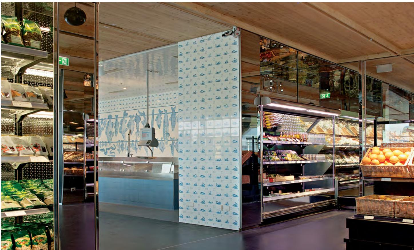
Holz ausgeführt ist, mit spiegelndem Edelstahlblech versehen. Den Bodenbelag bildet hier ein rutschhemmendes, 1,5 mm starkes Riffelblech aus nichtrostendem Stahl. Durch den Einsatz und die Veredelung industrieller Materialien wie Blech, Holz oder Asphalt entstand im Rahmen eines üblichen Gewerbebaubudgets ein Gebäude, das nicht nur durch seine Funktionalität, sondern auch durch seine anspruchsvolle architektonische Gestaltung und sorgfältige Detaillierung überzeugt.
