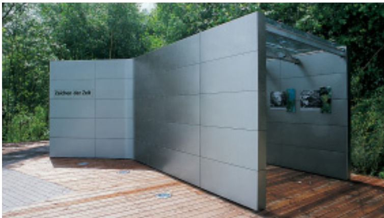
Les kiosques au parc d'expositions «Meteorit» à Essen (Allemagne) sont revêtus d'acier inoxydable gravé avec motifs en relief.
