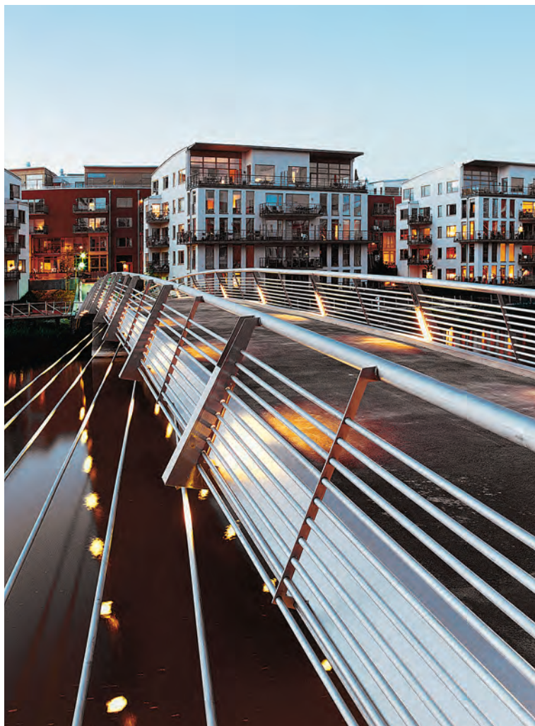
Passerelle en acier inoxydable de nuance 1.4462. Photo : SBI, Stockholm (S)
