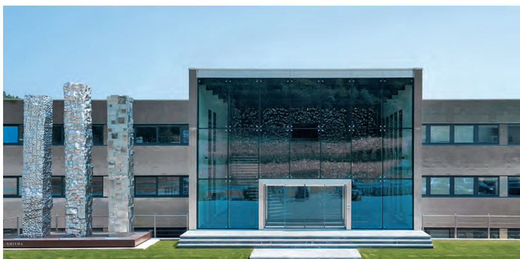
Façade en acier inoxydable duplex de nuance 1.4162. Photo : Montanstahl, Stabio (CH)
