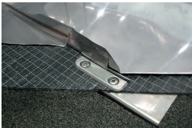
Finition 2B sous forme de toiture soudée en inox
